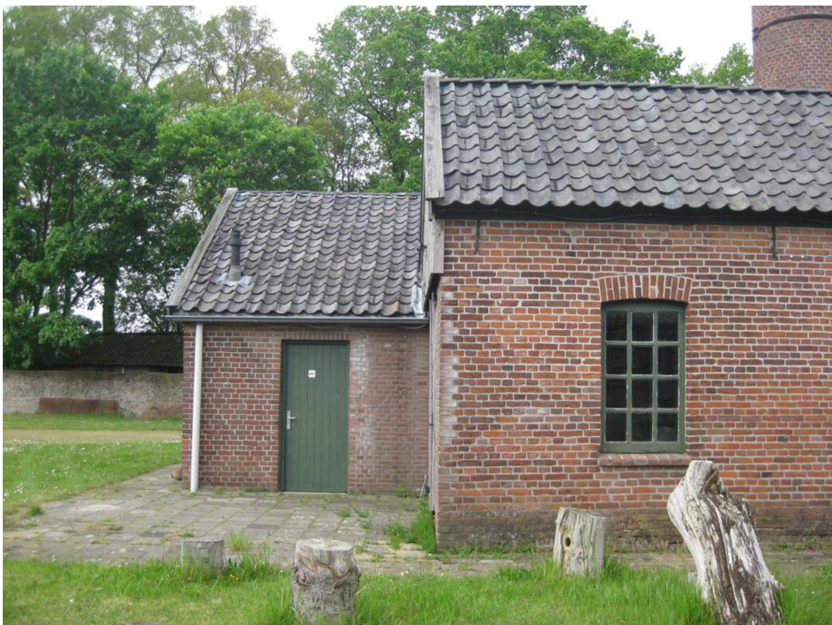
Ketelhuis en machinegebouw
