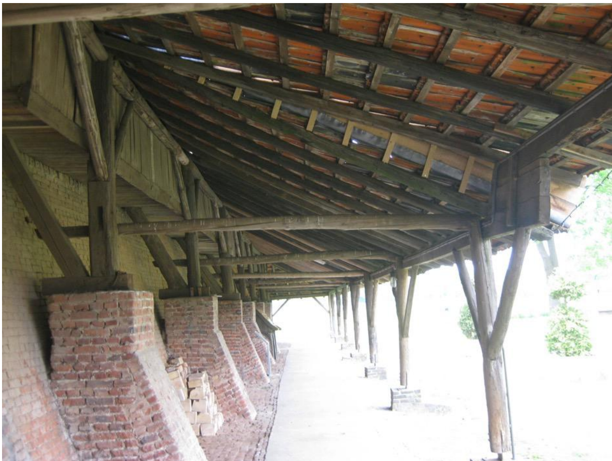
Lessenaarsdak onderbouw ringoven
