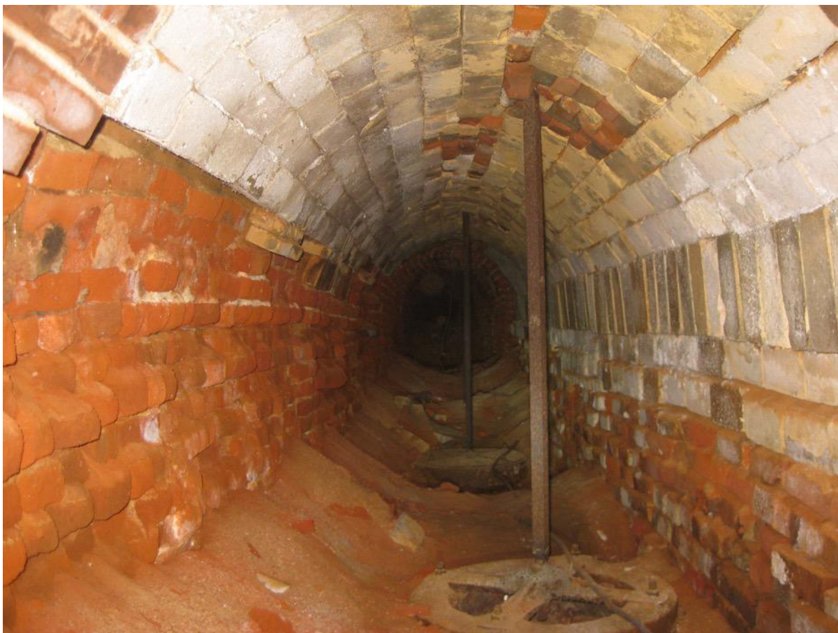
Rookkanaal onder de stookvloer, verpulverde stenen, gele stenen zijn vuurvaste steen
