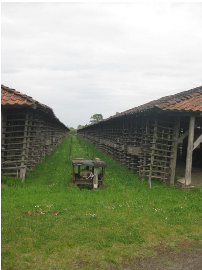
Kabelsysteem tussen droogloods 6 en 7
