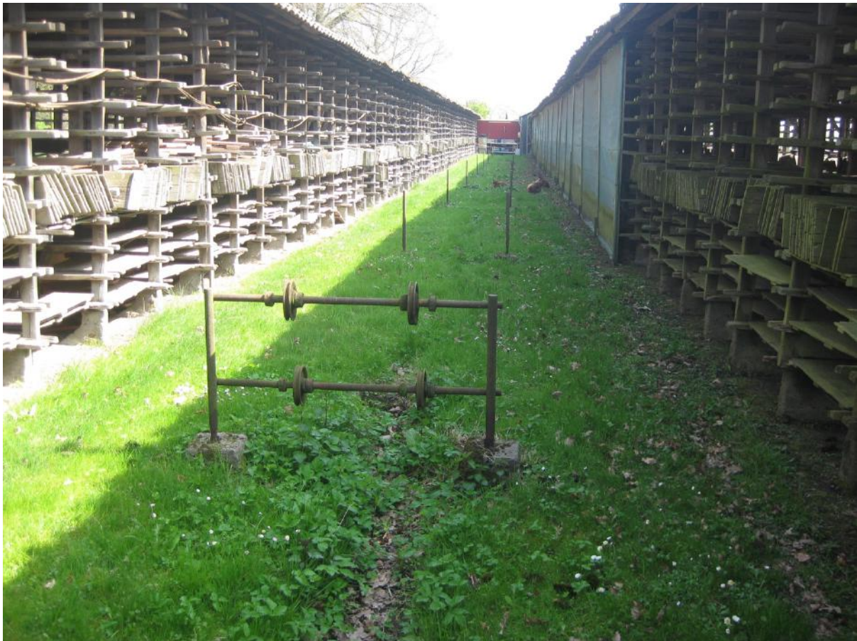
Kabelsysteem tussen droogloods 4 en 5
