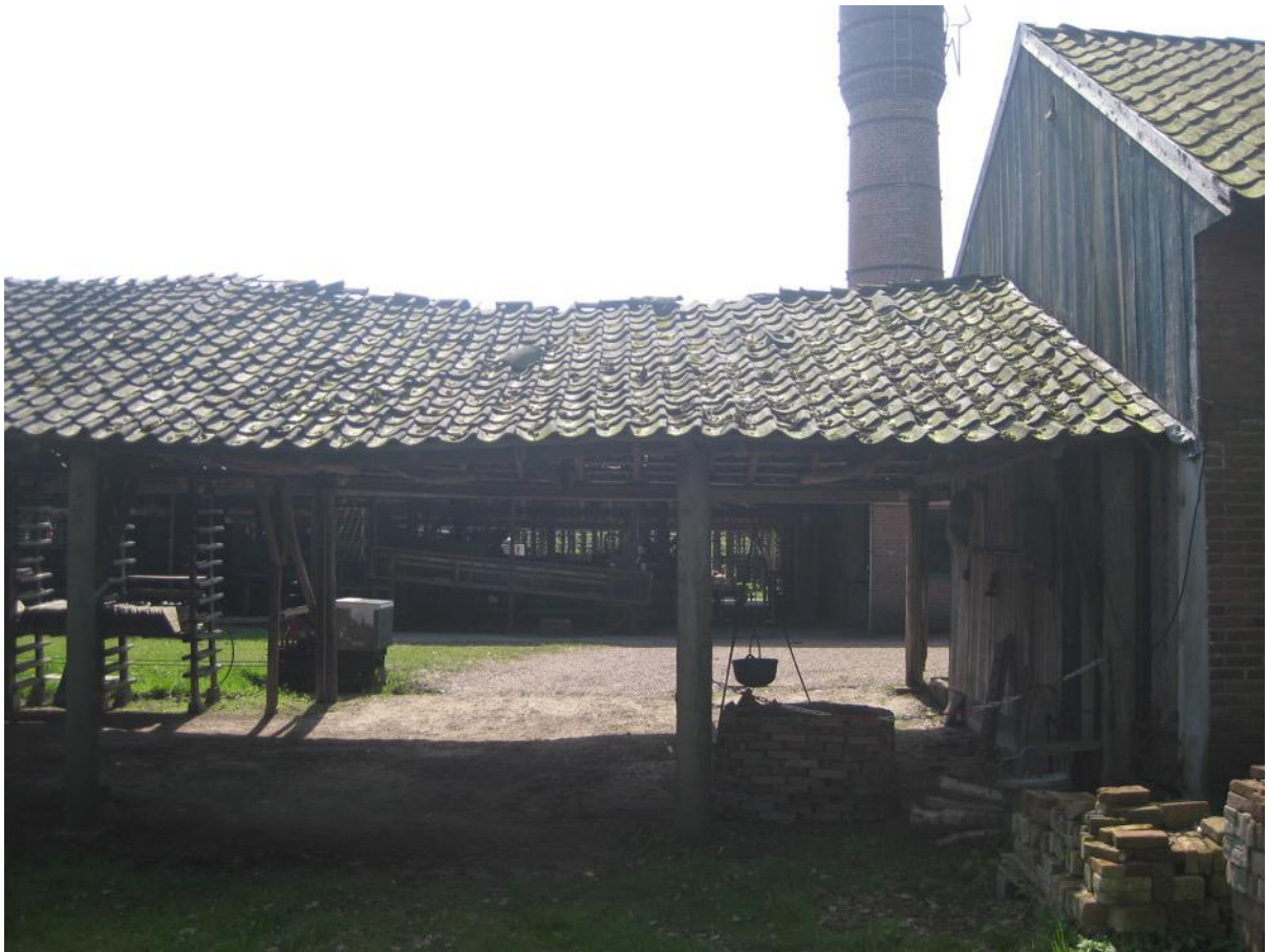
Droogloods 4 doorhangend dak
