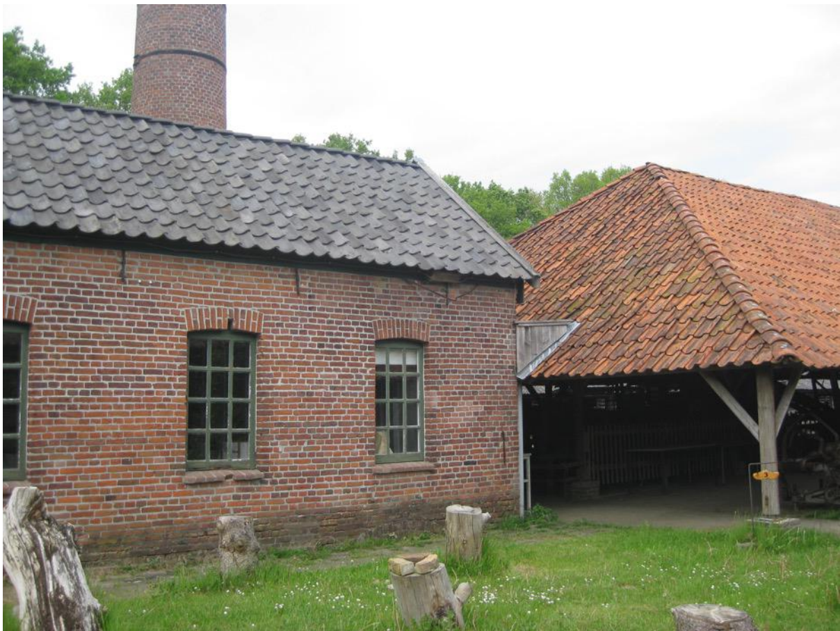
Ketelhuis en machinegebouw
