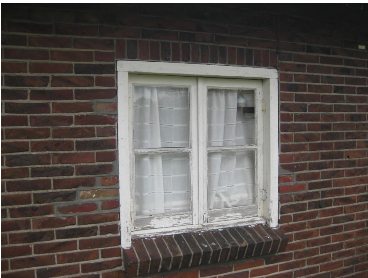
Kozijn directeursverblijf (voorgevel ringoven rechts)
