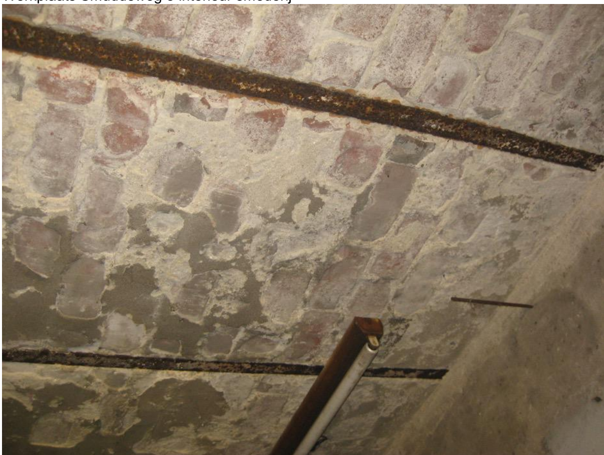
Werkplaats Smuddeweg 8 smederij baksteen vloer op stalen liggers
