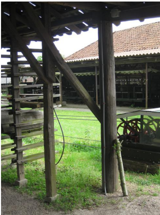
Droogloods 4 naar buiten geplaatst spant
