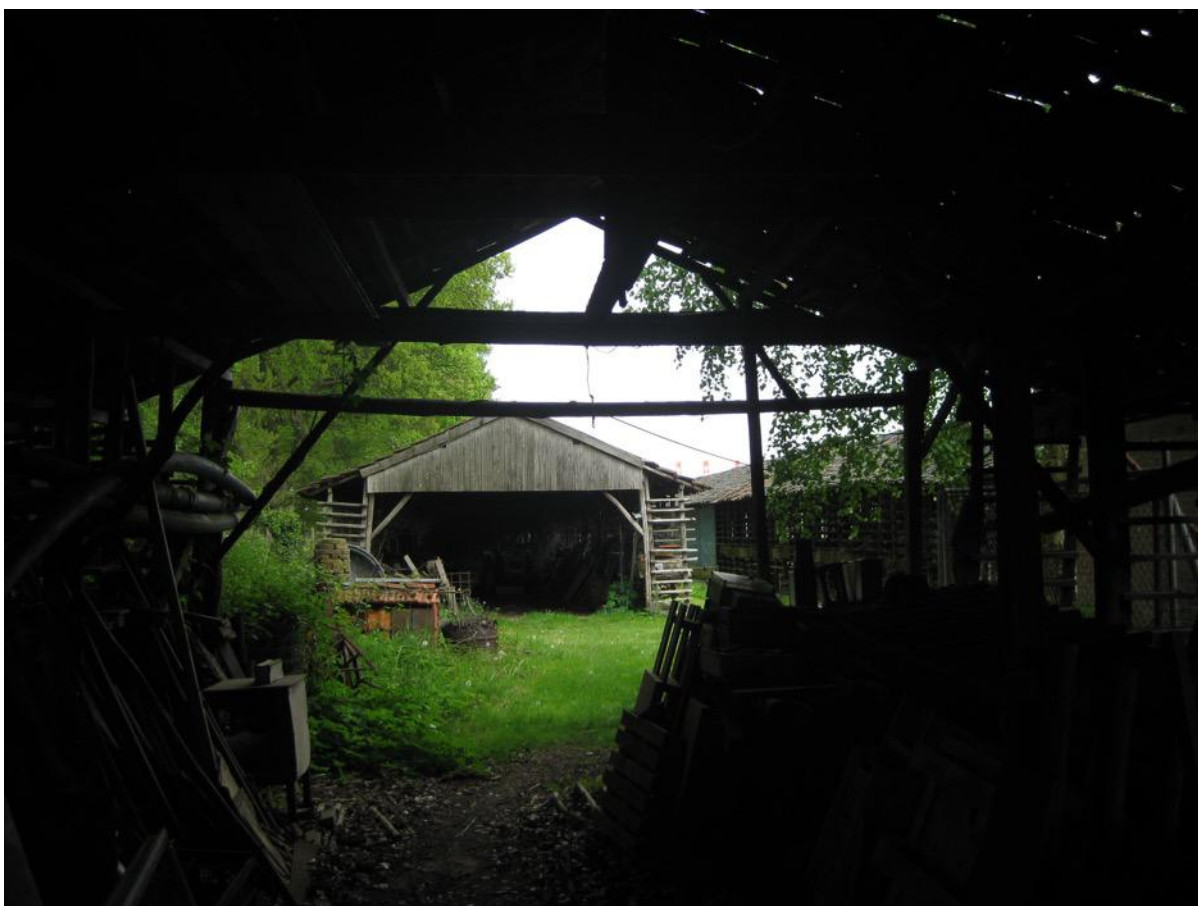
Droogloods 5 gezien vanuit 5a
