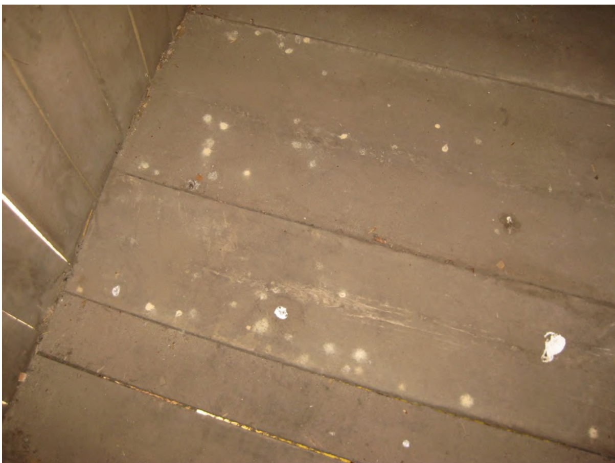
Vloerbeschoot uitkraging ringoven, aantasting houtworm
