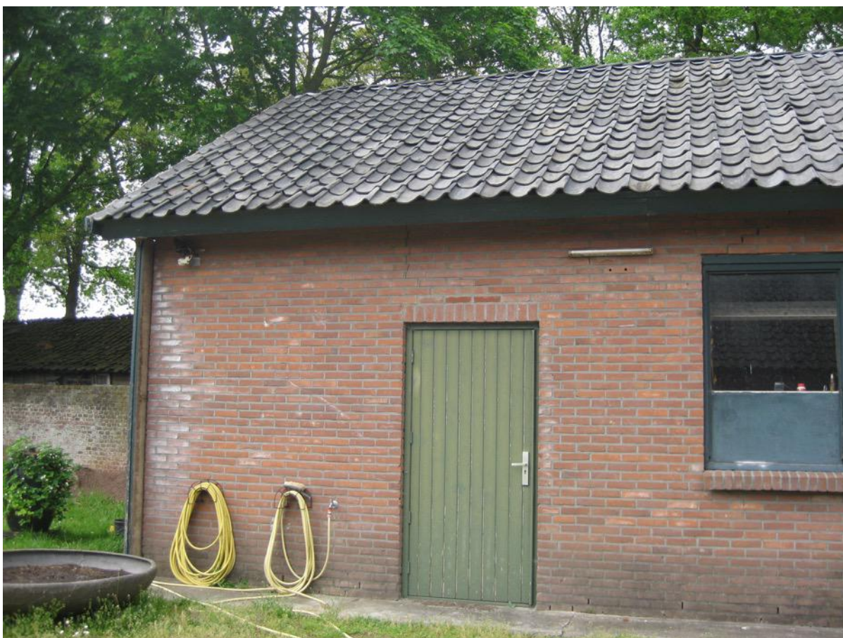
Werkplaats achter droogloods 4
