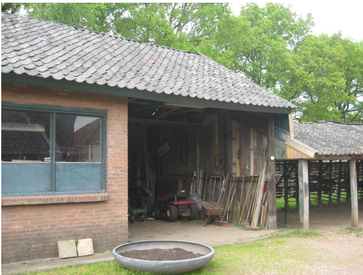
Werkplaats achter droogloods 4
