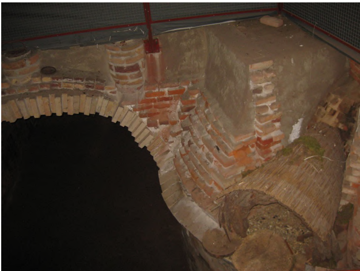
Opening in gewelf oven t.b.v. trap. Rechts losse stenen
