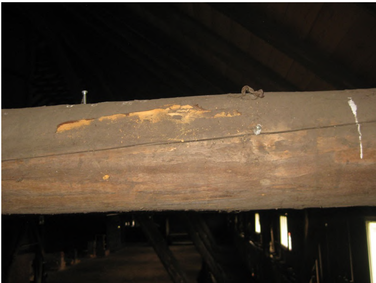
Detail spant kap ringoven, aantasting boktor
