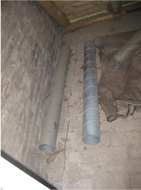
Bovenzijde baksteen vloer
