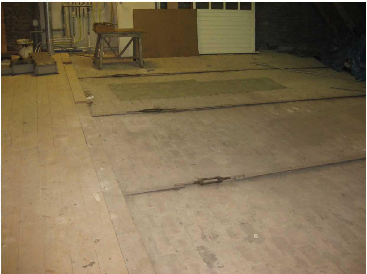
Baksteenvloer met trekankers
