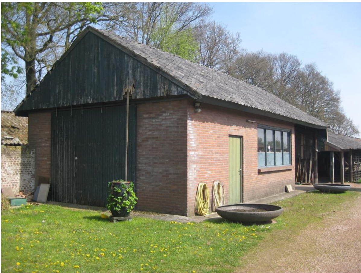
Werkplaats achter droogloods 4
