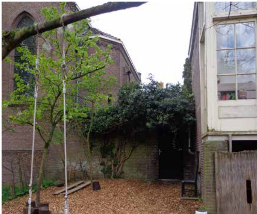
stadsmuur ten zuiden van de pastorie
