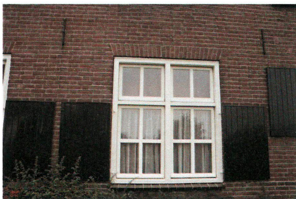
Venster in de rechterzijgevel
