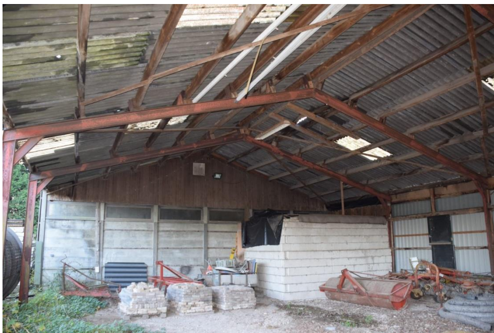
6 Open kapschuur aan de binnenzijde.
