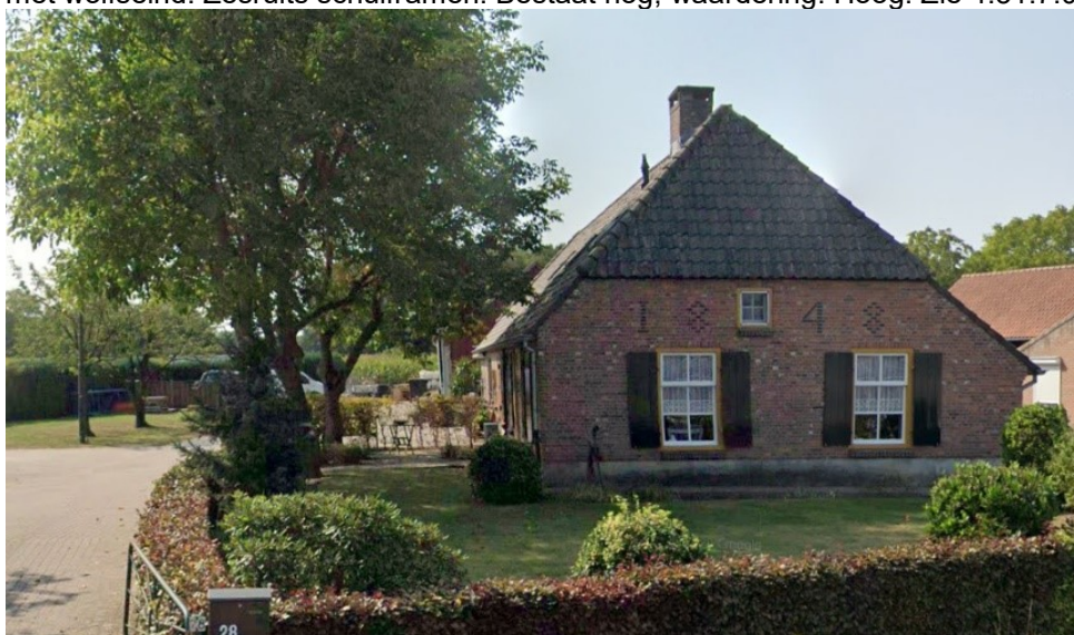
Mr. de la Courtstraat 28. GOOGLE STREETVIEW 2019.
