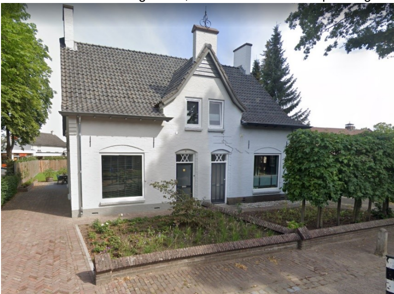
De verbouwde oude boterfabriek in Vessem. FOTO GOOGLE STREETVIEW.
