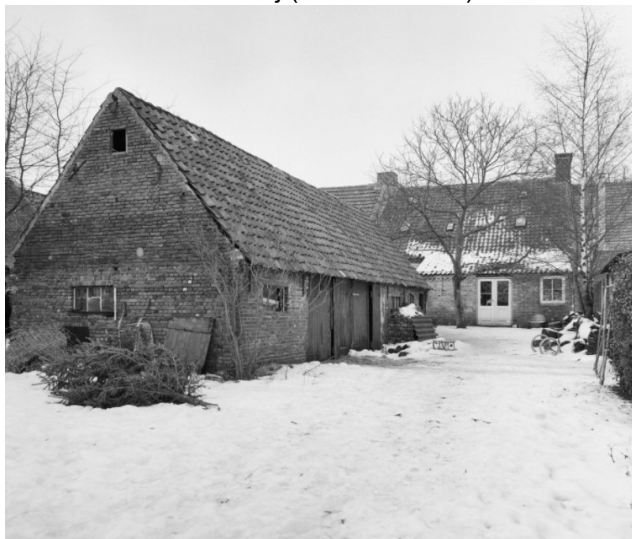
Achtergevel en schuur Markt 51 Eersel in 1979. RCE.
