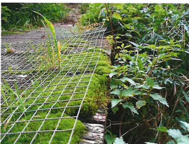
Foto 9: losliggende anti-slipvoorziening
