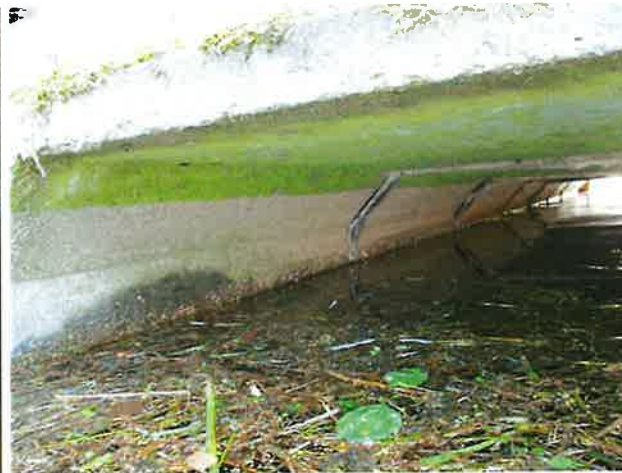
Foto 4: binnenzijde (Noord) duiker
