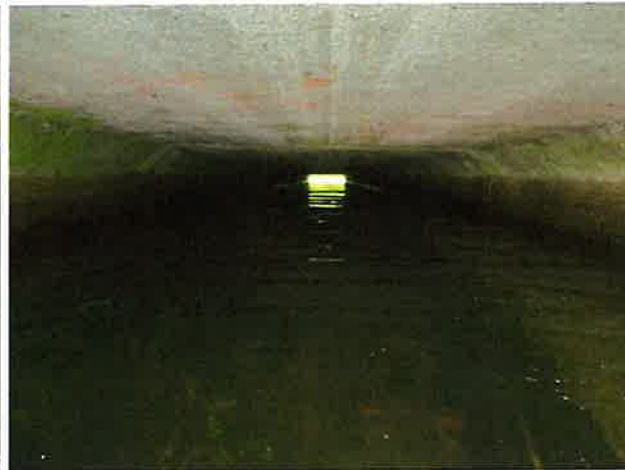
Foto 4: binnenzijde (Oost) duiker
