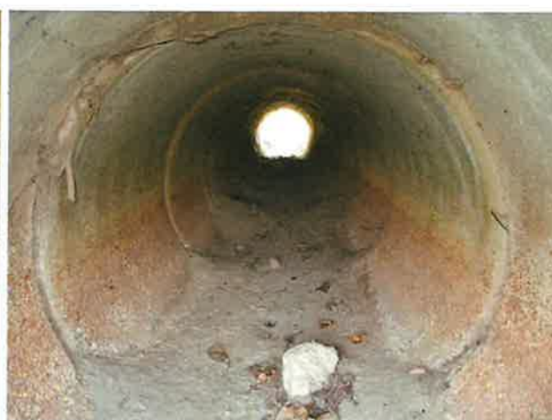
Foto 4: binnenzijde (Noord) duiker
