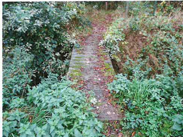
Foto 2: noordelijk aanzicht brug
