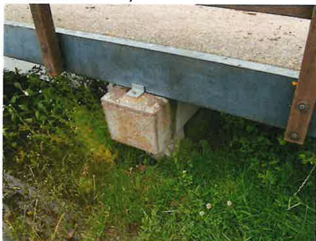
Foto 3: aanzicht bovenzijde tussensteunpunt
