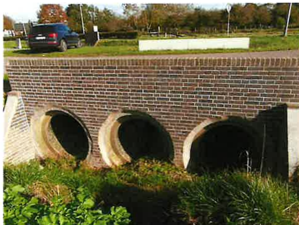
Foto 4: aanzicht borstwering west
