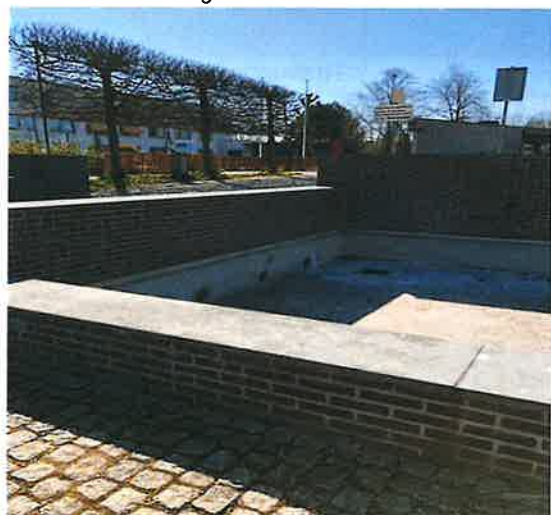
Foto 5: aanzicht pompput in bodem
