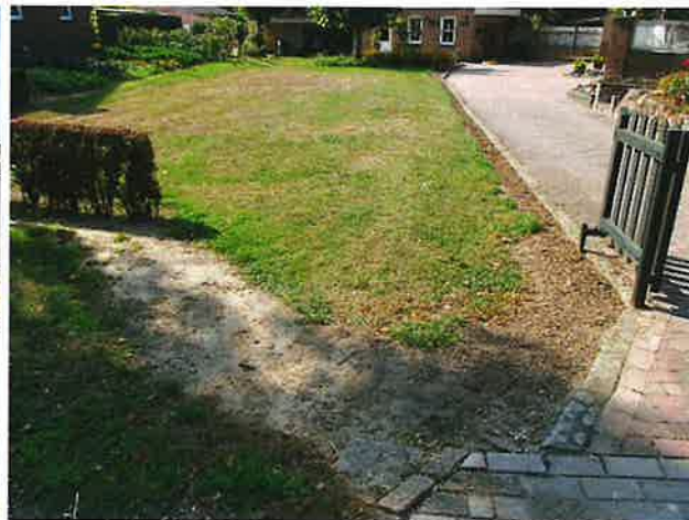
Foto 10: bovenaanzicht duiker (onder perceel)
