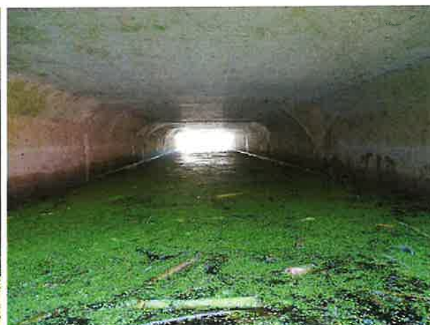
Foto 4: binnenzijde (Noord) duiker
