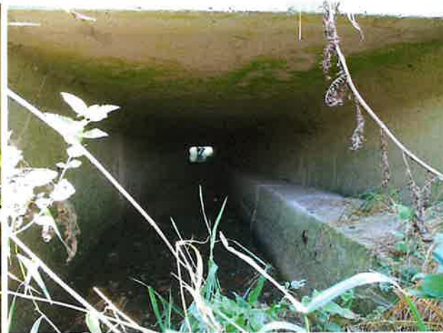
Foto 4: binnenzijde (West) duiker
