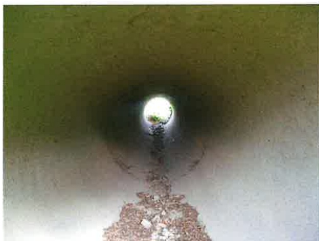
Foto 3: binnenzijde (zuid) duiker
