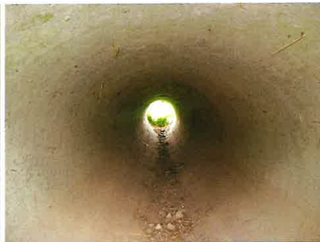
Foto 4: binnenzijde (noord) duiker
