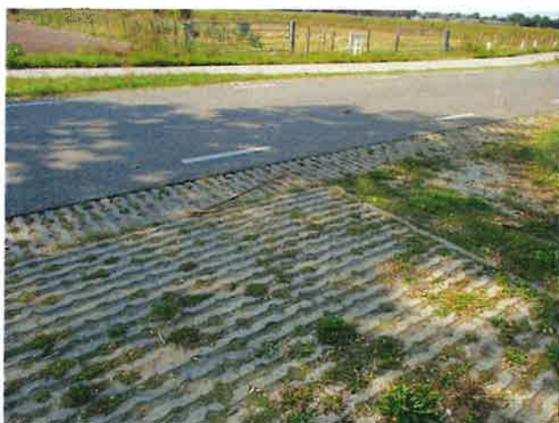
Foto 13: bovenaanzicht – berm met grasbetontegels
