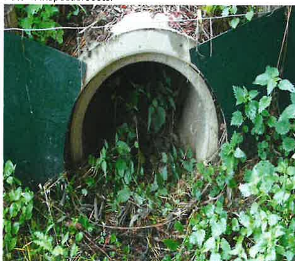
Foto 6: aanzicht amfibietunnel
