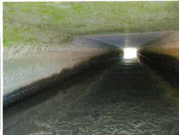
Foto 4: binnenzijde (Noord) duiker
