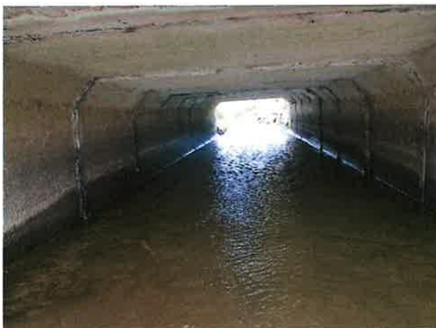
Foto 3: binnenzijde (Zuid) duiker
