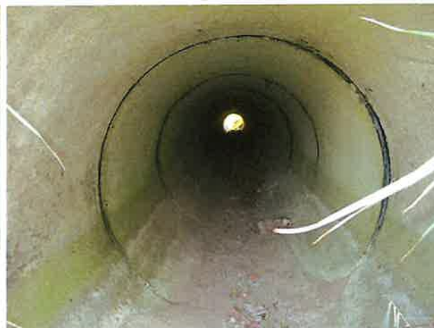
Foto 4: binnenzijde (noord) duiker
