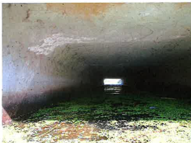
Foto 3: binnenzijde (Zuid) duiker
