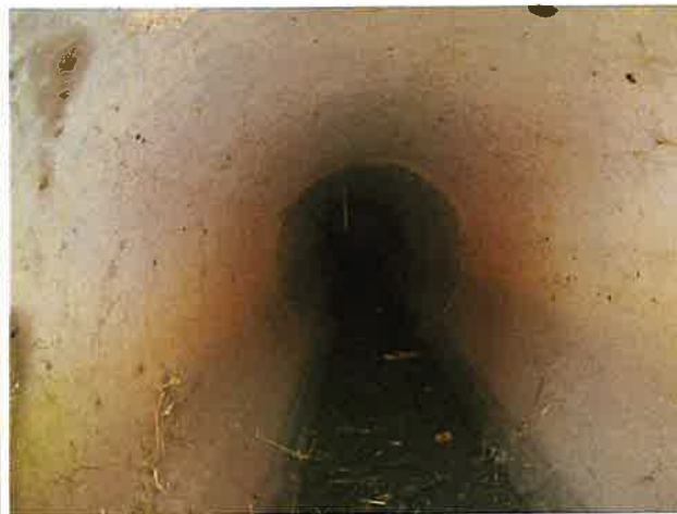
Foto 4: binnenzijde (west) duiker
