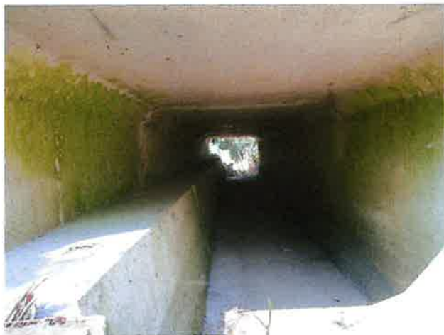
Foto 3: binnenzijde (Zuid) duiker
