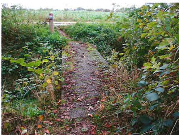
Foto 3: zuidelijk aanzicht brug
