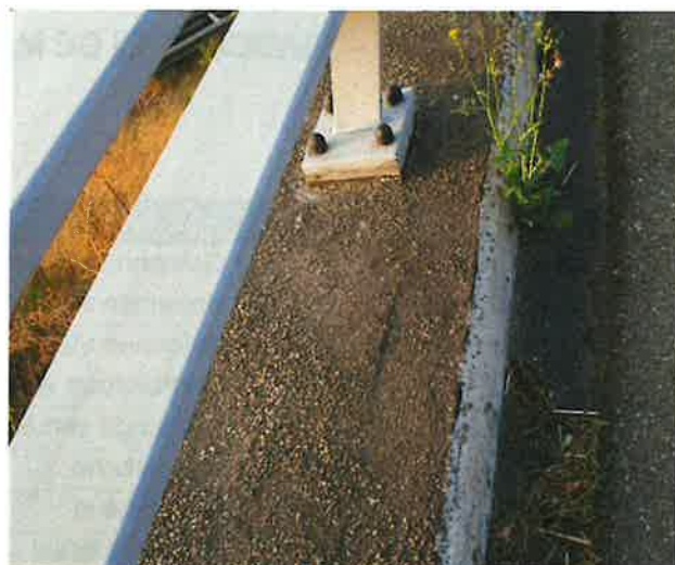
Foto 2: aanzicht gietasfaltgoot
