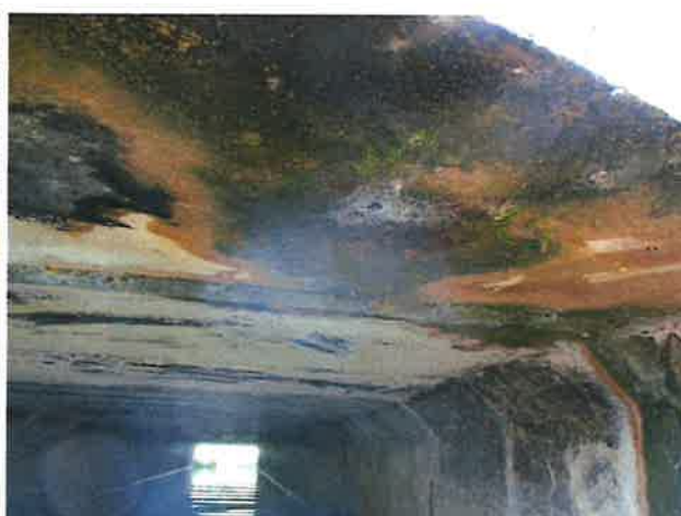
Foto 4: binnenzijde (Noord) duiker
