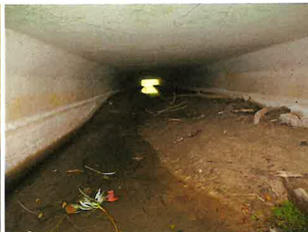
Foto 4: binnenzijde (Oost) duiker
