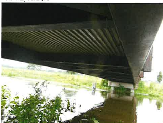
Foto 4: aanzicht tussensteunpunt en onderzijde dek
