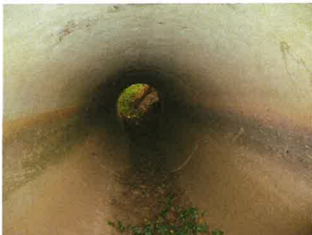
Foto 3: binnenzijde (Oost) duiker
