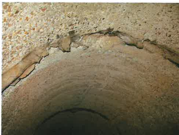
Foto 9: aanzicht kanteling buiselement
