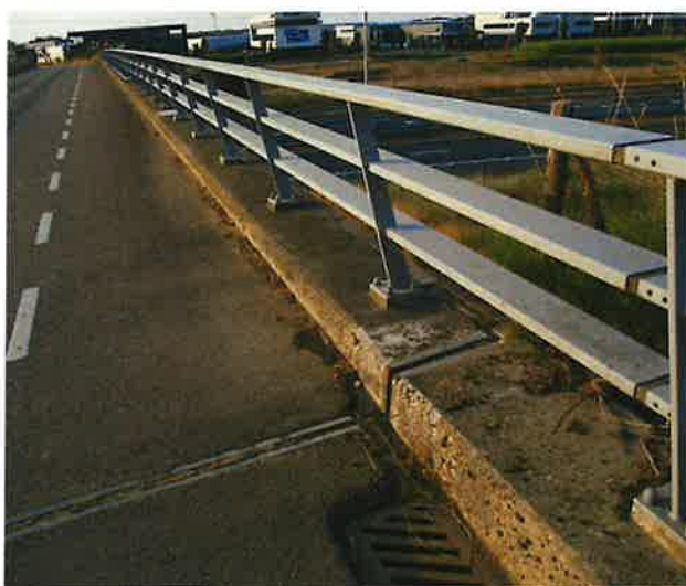
Foto 2: aanzicht asfaltverharding en leuning
