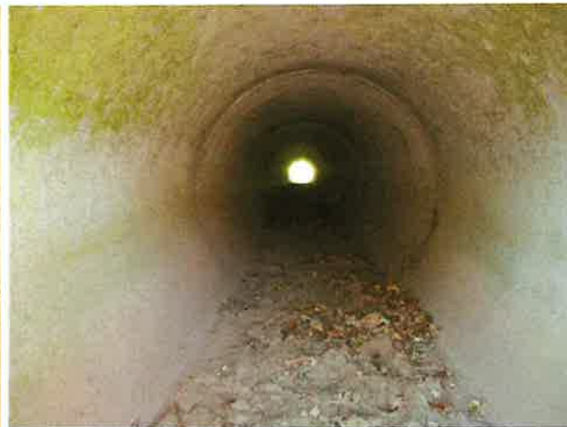
Foto 4: binnenzijde (noord) duiker
