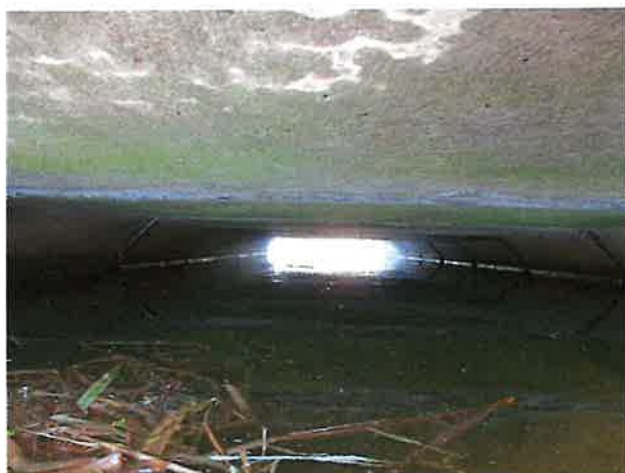
Foto 3: binnenzijde (Zuid) duiker
