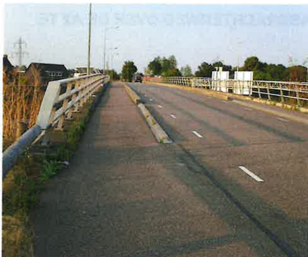
Foto 1: aanzicht bovenzijde viaduct
