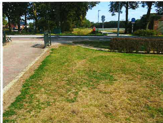
Foto 8: bovenaanzicht duiker (onder perceel)
