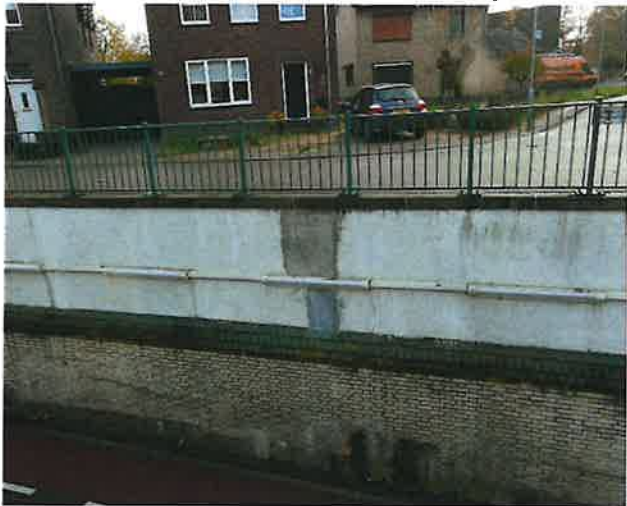
Foto 11: defecte dilatatievoeg
