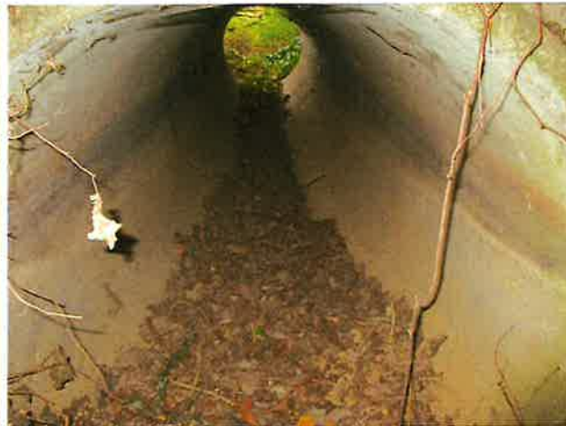
Foto 4: binnenzijde (West) duiker
