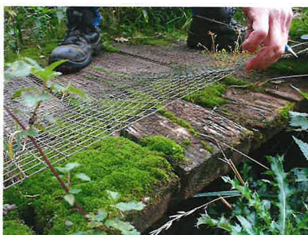
Foto 8: losliggende anti-slipvoorziening
