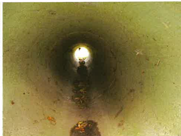
Foto 4: binnenzijde (west) duiker
