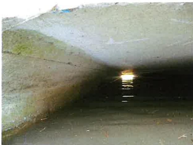
Foto 3: binnenzijde (Oost) duiker
