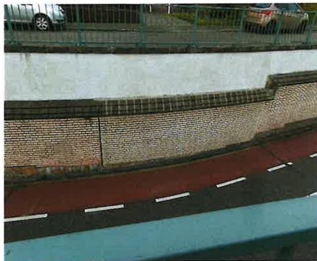
Foto 2: aanzicht herstelde vleugelwanddeel
