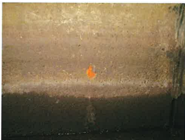
Foto 11: aanzicht dekkingschade
