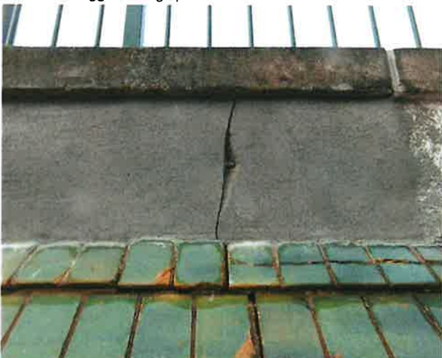
Foto 12: defecte dilatatievoeg
