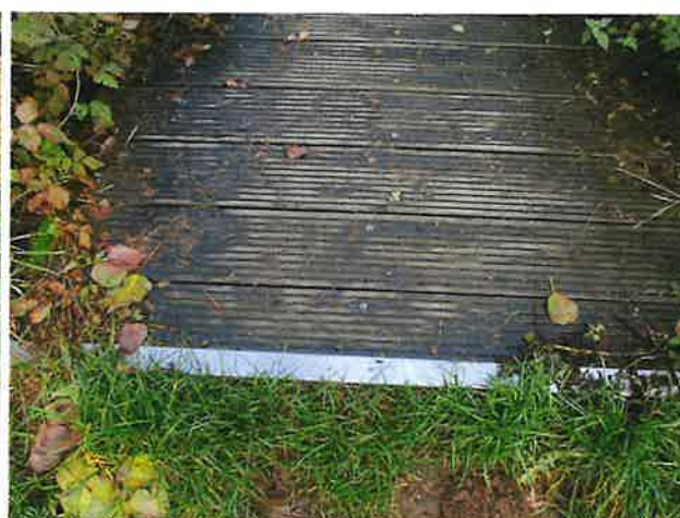
Foto 6: aanzicht beëindigingsprofiel
