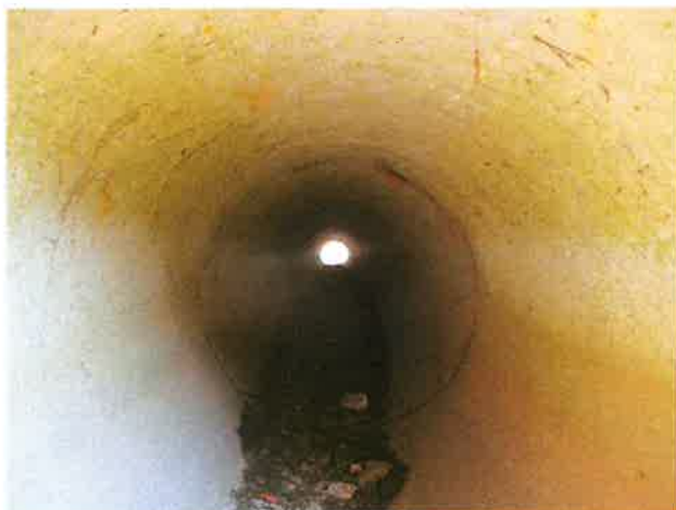
Foto 3: binnenzijde (zuid) duiker
