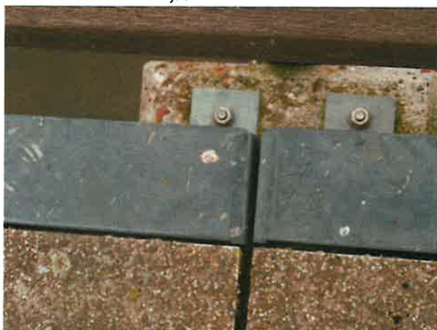
Foto 3: aanzicht bovenzijde tussensteunpunt
