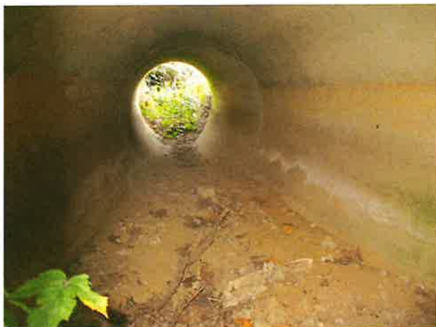
Foto 3: binnenzijde (west) duiker
