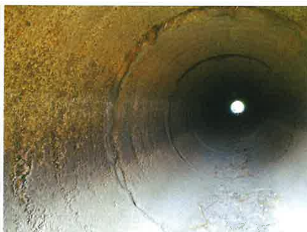
Foto 10: aanzicht kanteling buiselement
