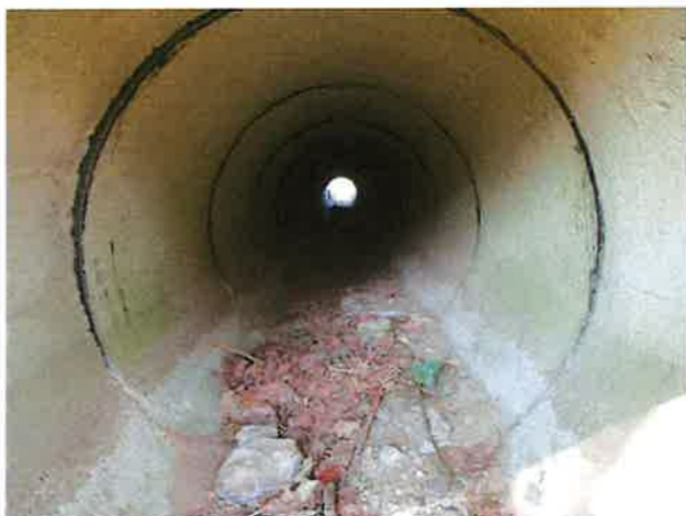
Foto 3: binnenzijde (zuid) duiker
