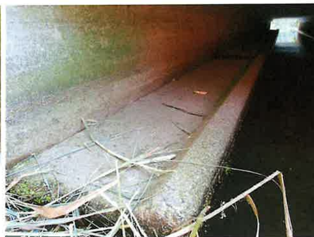
Foto 4: binnenzijde (Noord) duiker
