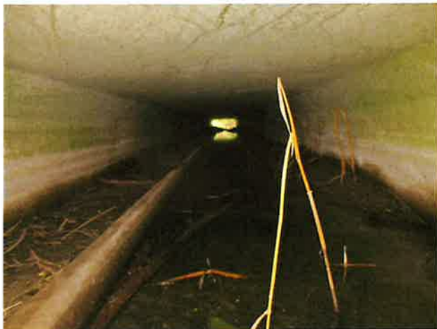
Foto 3: binnenzijde (West) duiker
