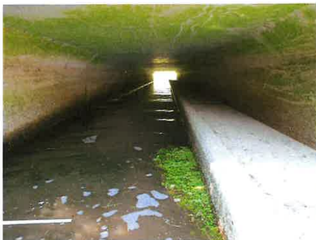
Foto 3: binnenzijde (Zuid) duiker
