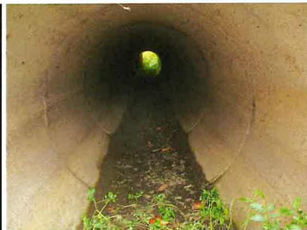
Foto 4: binnenzijde (West) duiker
