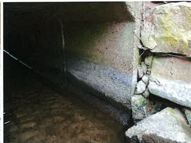
Foto 16: aanzicht erosie
