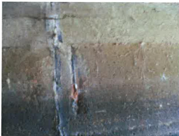
Foto 9: aanzicht dekkingschade
