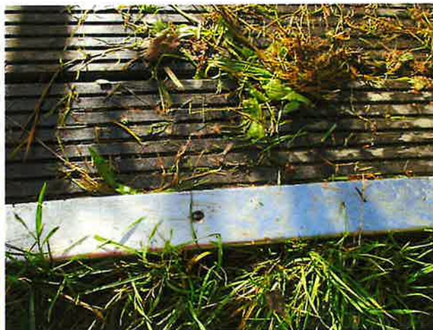
Foto 16: ontbrekende schroef
