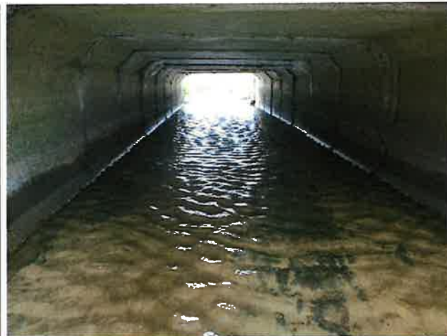
Foto 4: binnenzijde (Noord) duiker
