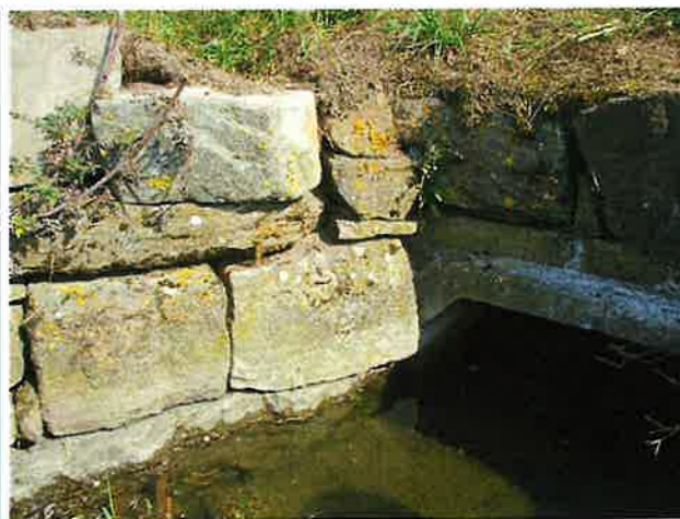
Foto 8: keerwand - vleugelwand
