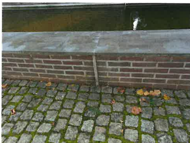
Foto 3: aanzicht voeg en muurafdekker
