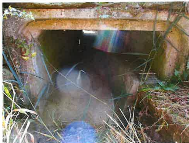
Foto 4: binnenzijde (Noord) duiker
