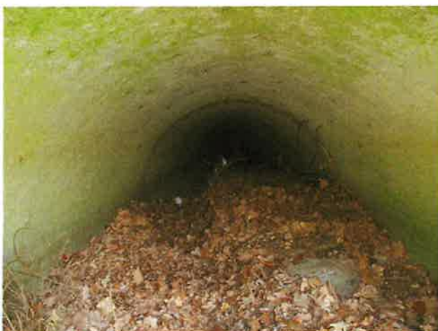
Foto 3: binnenzijde (Zuid) duiker
