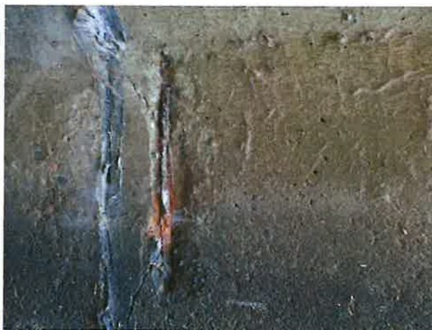
Foto 10: aanzicht dekkingschade
