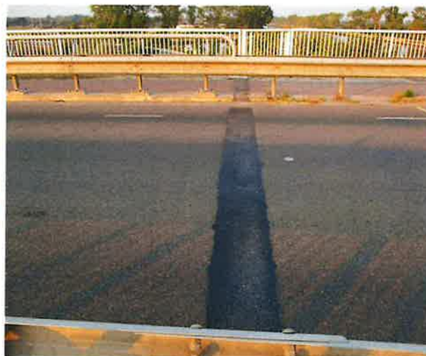
Foto 2: aanzicht asfaltverharding
