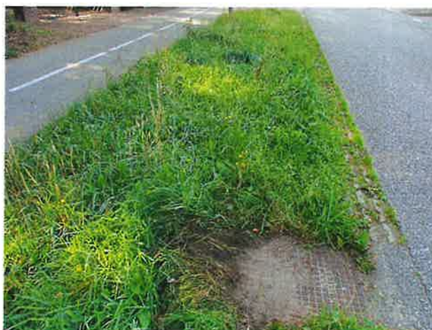
Foto 11: inspectieput (met hoek)
