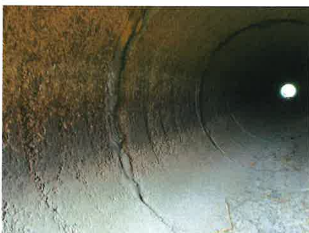
Foto 12: aanzicht erosie
