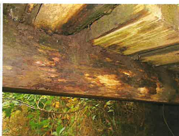
Foto 10: oppervlakkige houtverwerking
