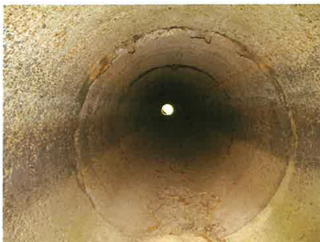
Foto 3: binnenzijde (west) duiker
