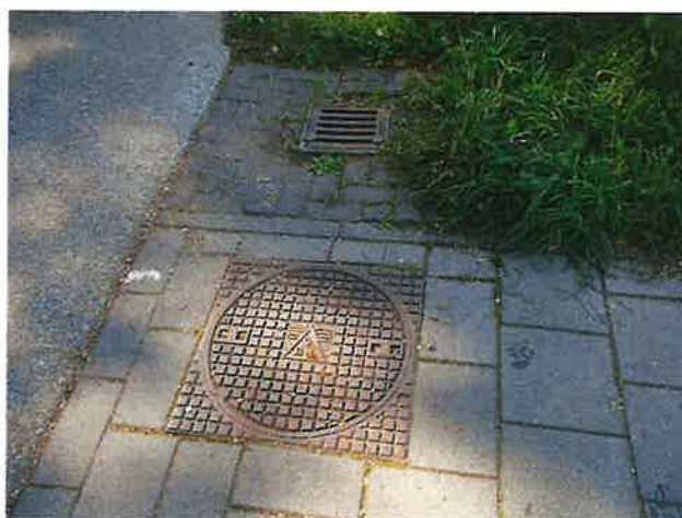
Foto 9: inspectieput met kolk
