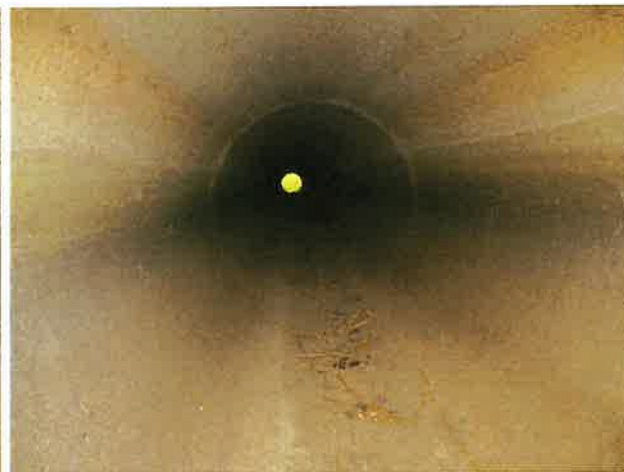
Foto 4: binnenzijde (oost) duiker
