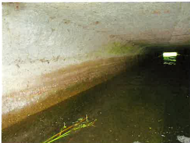
Foto 3: binnenzijde (West) duiker
