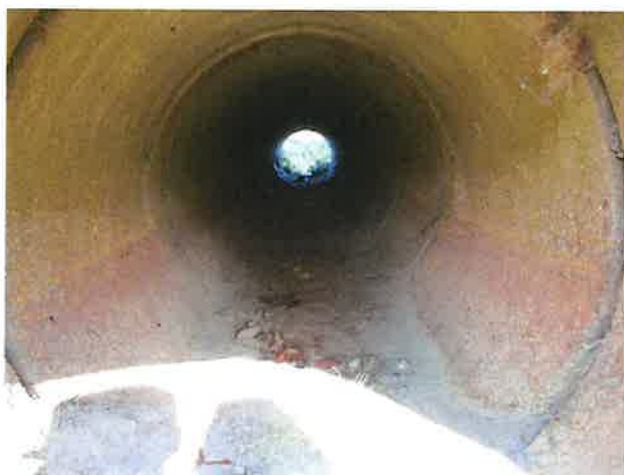
Foto 3: binnenzijde (Zuid) duiker
