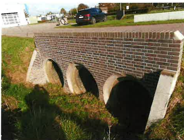
Foto 3: aanzicht borstwering west
