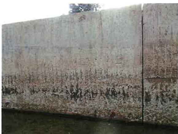
Foto 11. Aanzicht erosie-dekkingschade
