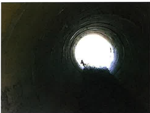
Foto 3: binnenzijde (Oost) duiker
