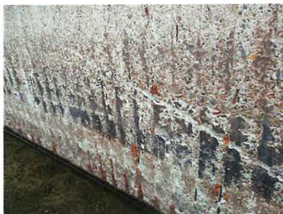
Foto 12. Aanzicht erosie-dekkingschade
