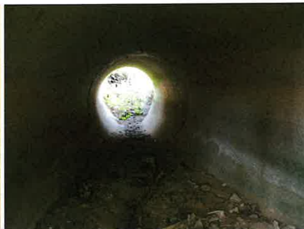
Foto 4: binnenzijde (west) duiker
