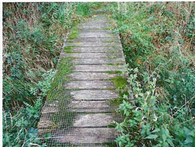
Foto 2: noordelijk aanzicht brug
