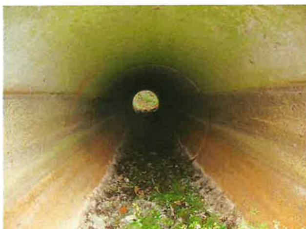
Foto 3: binnenzijde (Oost) duiker
