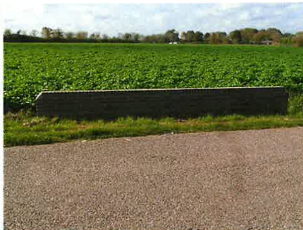
Foto 2: aanzicht borstwering west
