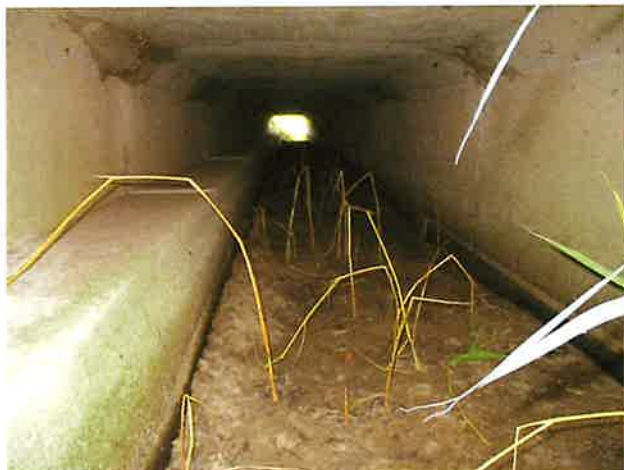
Foto 3: binnenzijde (Oost) duiker
