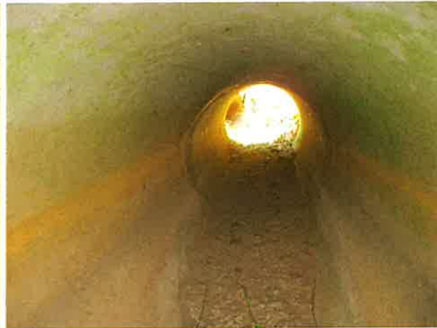
Foto 4: binnenzijde (oost) duiker
