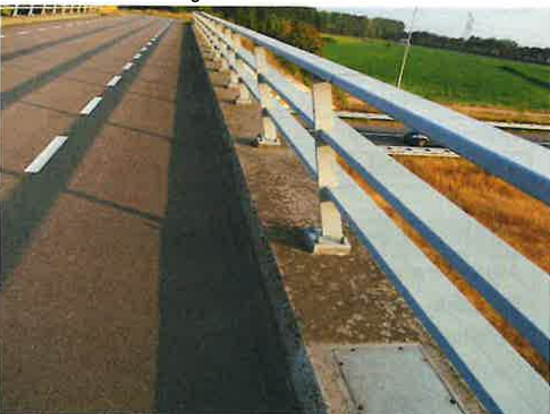
Foto 6: aanzicht asfaltverharding met gietasfaltgoot
