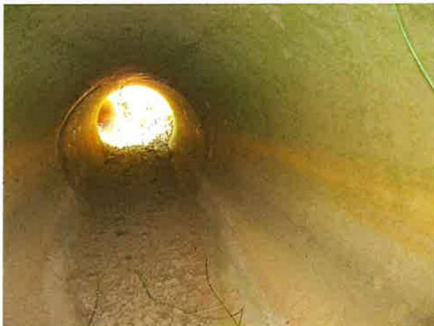
Foto 3: binnenzijde (oost) duiker
