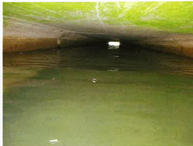
Foto 4: binnenzijde (West) duiker
