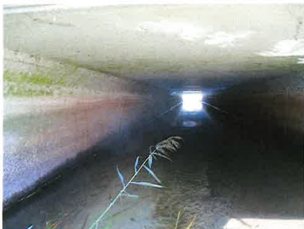
Foto 3: binnenzijde (Zuid) duiker
