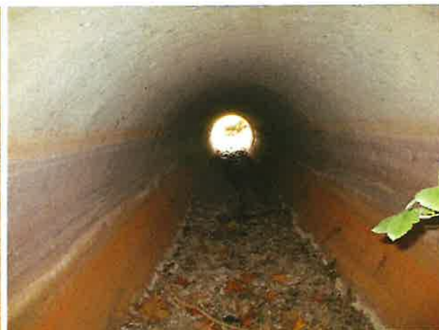
Foto 4: binnenzijde (West) duiker
