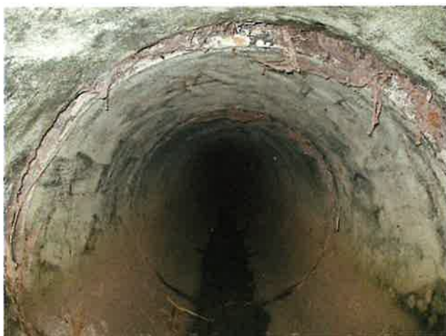
Foto 3: binnenzijde (oost) duiker
