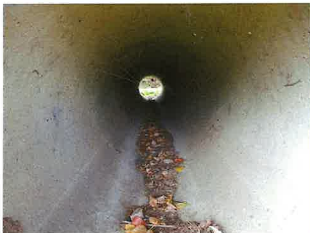
Foto 3: binnenzijde (oost) duiker
