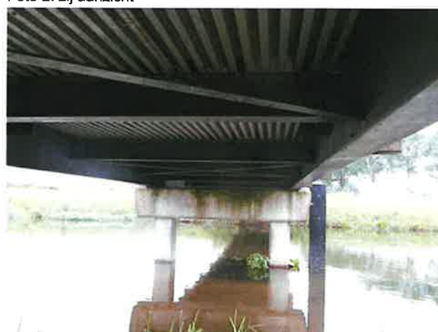
Foto 4: aanzicht tussensteunpunt en onderzijde dek
