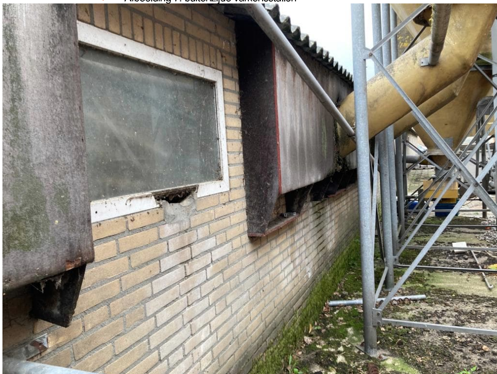
• Afbeelding 7: buitenzijde varkensstallen
