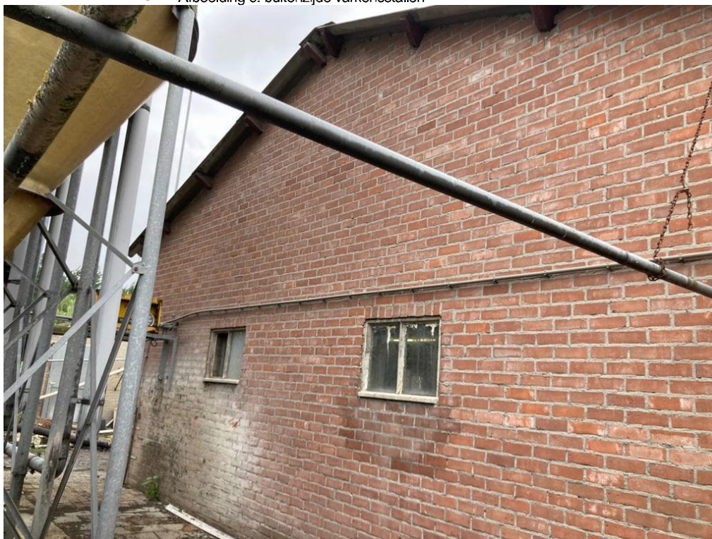
• Afbeelding 8: buitenzijde varkensstallen
