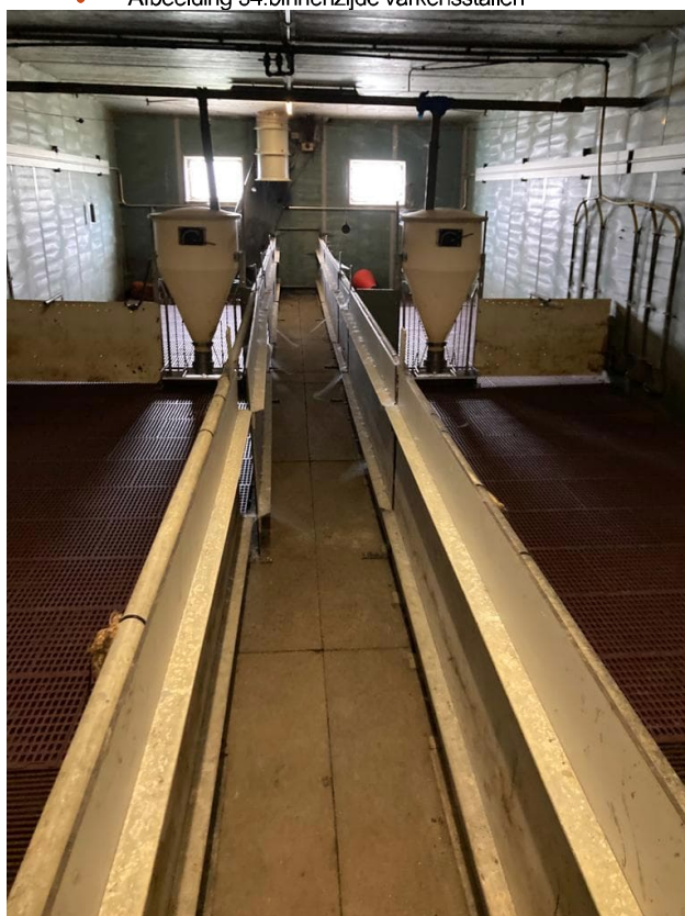
• Afbeelding 34: binnenzijde varkensstallen
