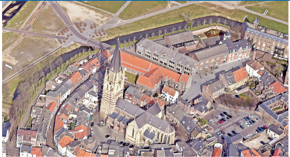
Gracht waarin zichtbaar hemelwater opgevangen kan worden
