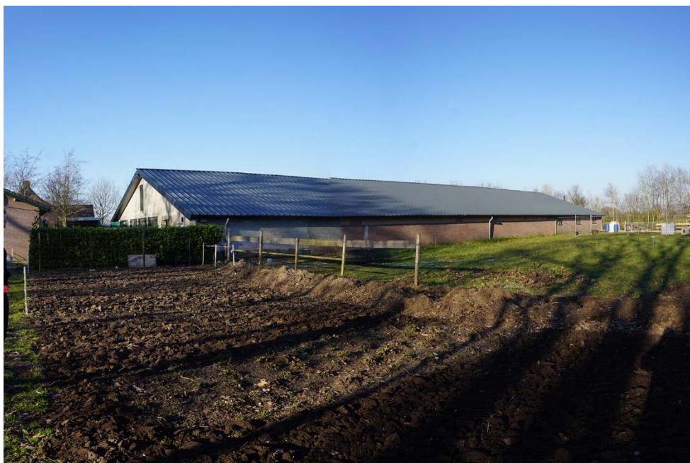
De schuur, in gebruik als keuken voor de dagbesteding, vergaderruimte en opslag van materialen.
