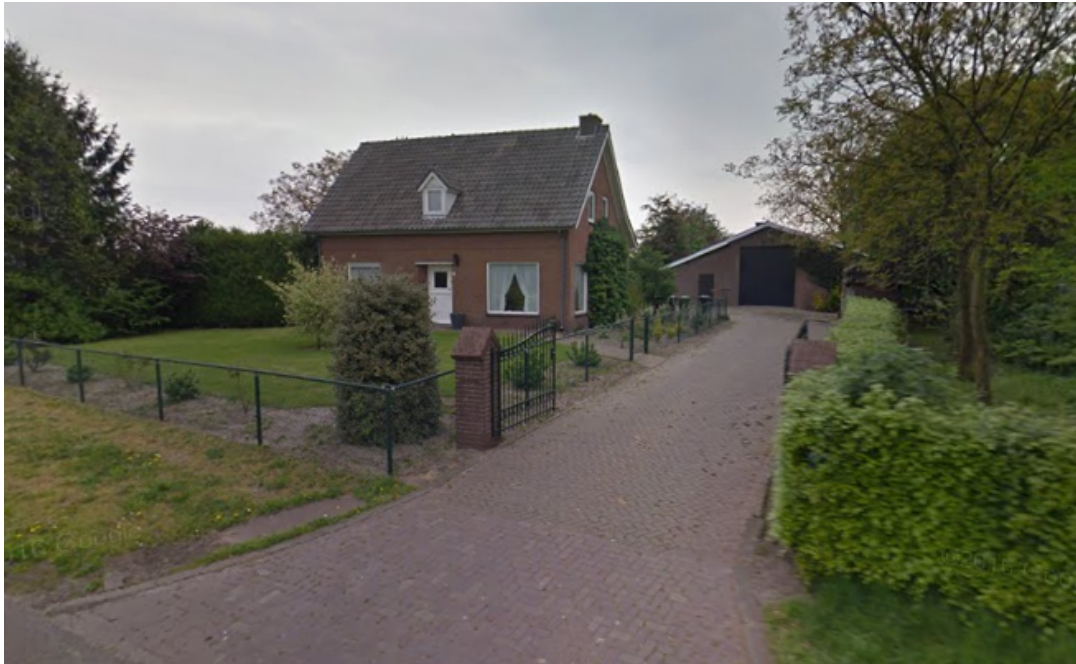
Het plangebied gezien vanaf de straatzijde met op de achtergrond de voormalige varkensstal
