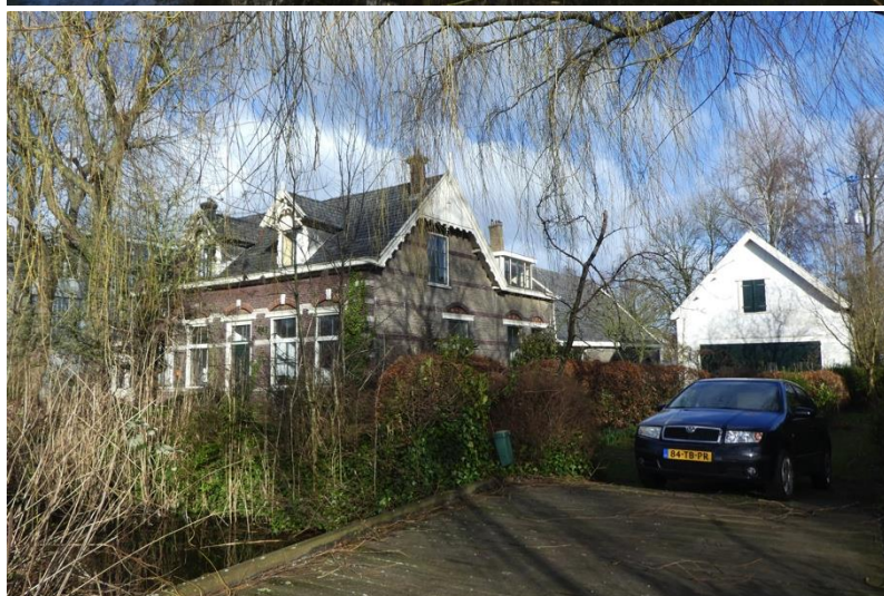
Perceel gezien vanuit het oosten met wagenschuur, 2020
