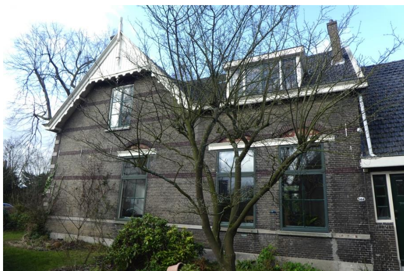
Zijgevel boerderij woonhuis, 2020.
