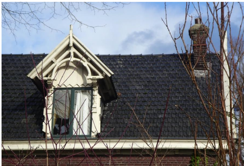
Detail voorgevel dakkapel, 2020.
