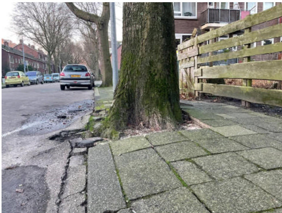
Foto 9: Beeld van de moeraseik met boomnummer 38 met wortelopdruk ter hoogte van de rijweg en stoep.
