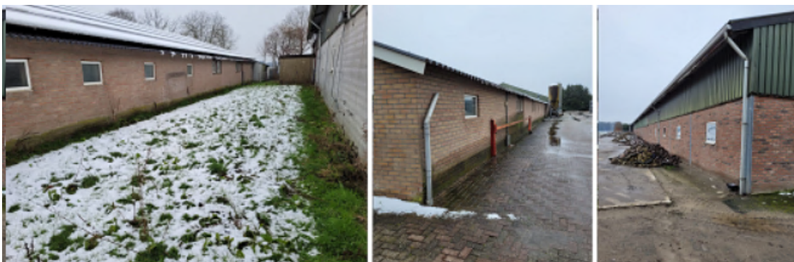
Afbeelding 4.1: foto's van bestaande situatie dakvlak/groenzone/afvoer
