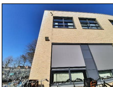
Figuur 6. Gevel op onderzoekslocatie.
