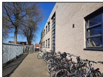
Figuur 5. Bebouwing binnen onderzoekslocatie, zuidwestelijke zijgevel.
