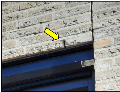
Figuur 10. Voorbeeld van open stootvoeg met rooster.
