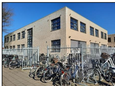
Figuur 3. Impressie onderzoekslocatie, kijkrichting noordoosten.
