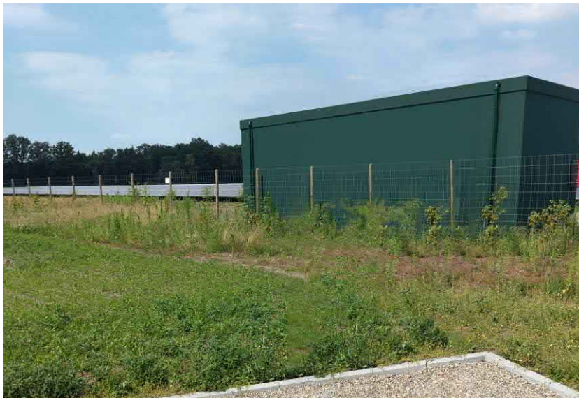
Figuur 8: Bestaande inkoopstation bij zonnepark Masterveldweg
