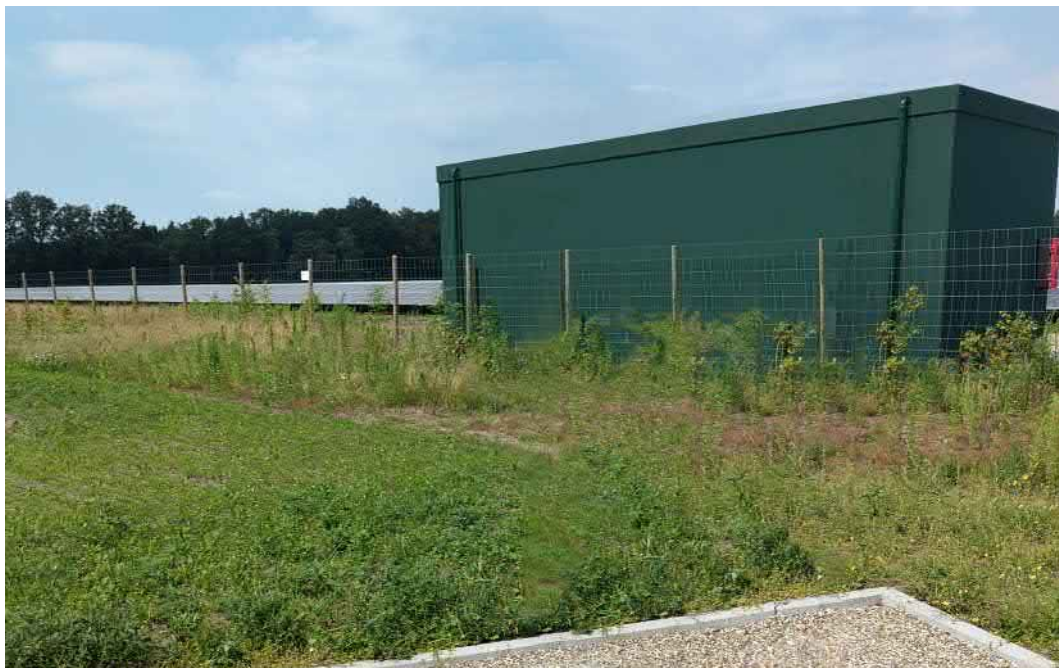
Afbeelding 5. Het bestaande inkoopstation bij de entree van het zonneveld. Links hiervan wordt een nieuw inkoopstation gebouwd met hetzelfde kleur-, materiaalgebruik en hoogte maar kleiner: 3 bij 5 meter.
