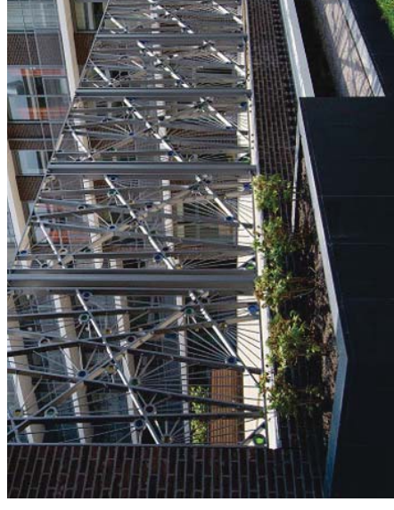
Een hekwerk met het gebouw mee ontworpen, enkel als toegang tot gemeenschappelijk binnengebied. De rest van afscheiding bestaat uit een muur.
