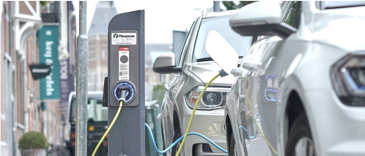
Afbeelding 1: Publieke laadpaal Vattenfall (Vattenfall, 2022)
