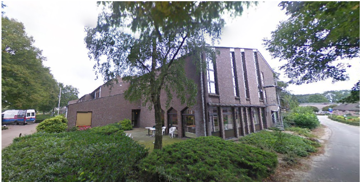
Aanzicht bebouwing voormalig Verzorgingshuis Huize Loôn vanaf hoek Engelseweg en Derpshei
