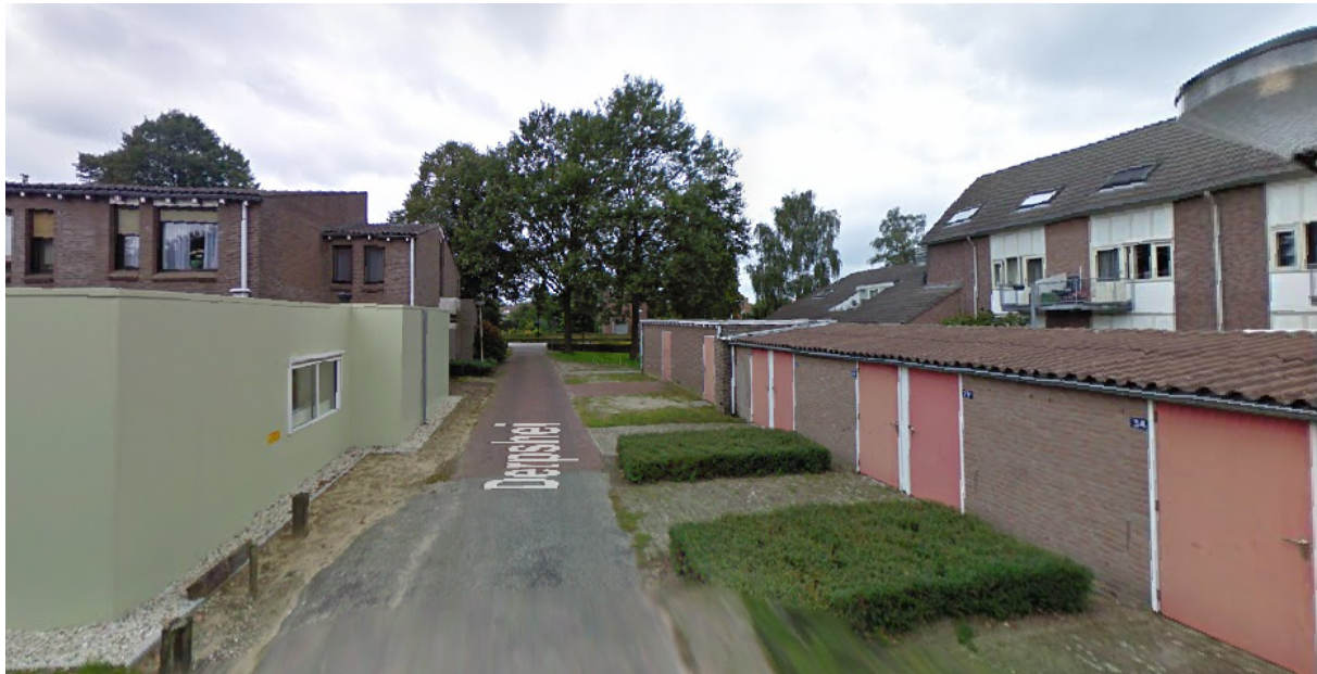
Aanzicht bebouwing voormalig verzorgingshuis Huize Loon (links) t.o.v. achterzijde woonbebouwing Theobaldusweg (rechts) vanaf Derpshei
