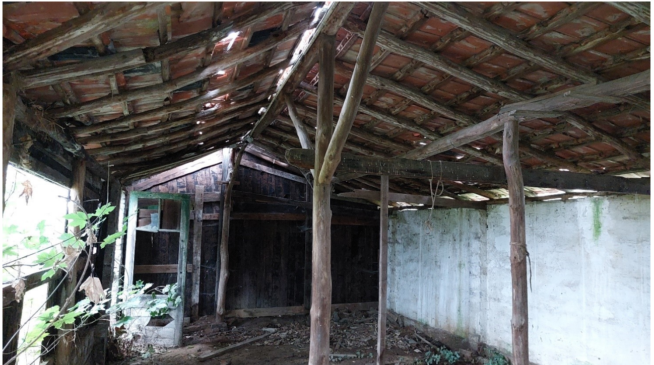
Figuur 4.4.4. De opstallen zijn geheel enkelwandig.
