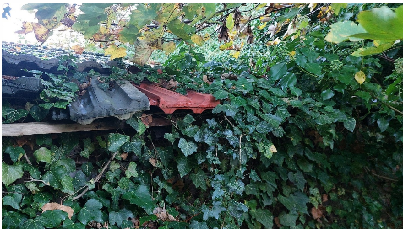
Figuur 4.4.2. De dakrand met daar bovenop mulden dakpannen is overgroeid met klimop; algemene vogels kunnen in de klimop nestelen, maar huismussen en vleermuizen hebben hier geen toegang.
