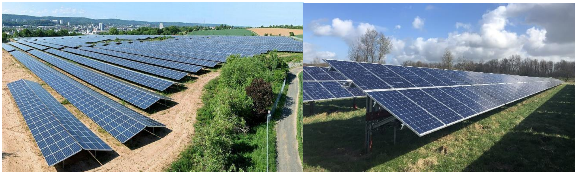
Figuur 14: Voorbeelden van oriëntatie opstelling zonnepark. Oost-west (links), zuid (rechts).
