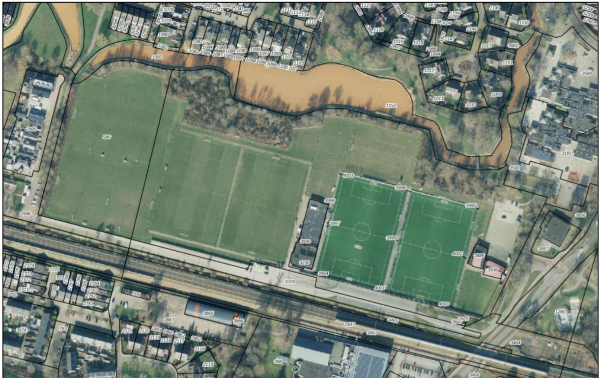
Afbeelding 2.1 luchtfoto bestaande situatie bron: www.Pdok.nl
