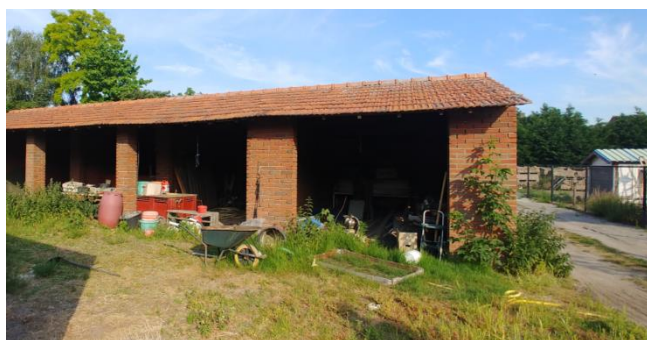
Figuur 8: Opstal tegen de zuidelijke erfgrans
