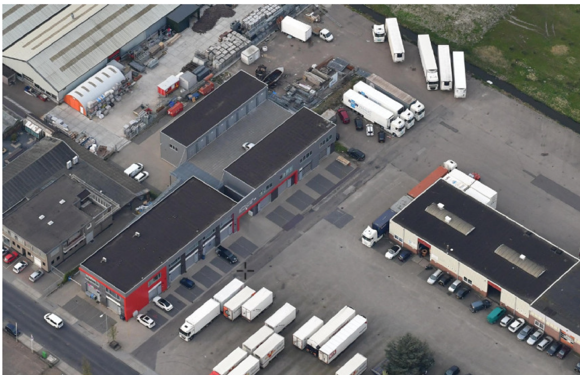
Huidige situatie Bovendijk 18
