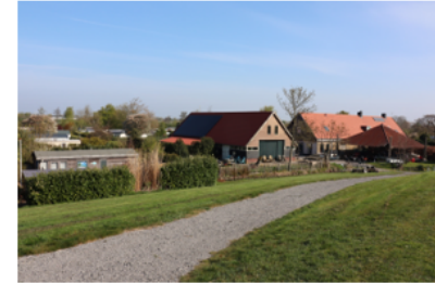
Bedrijfsgebouwen van het vakantiepark.
