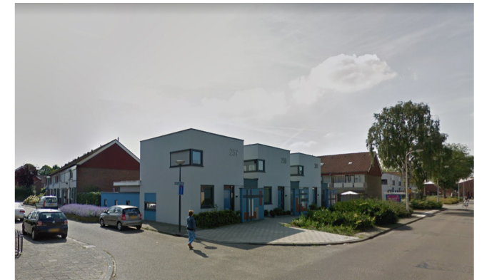
Elferinkweg, na kleinschalige vernieuwing. De nieuwbouw volgt de oorspronkelijke opzet. Goed zichtbaar zijn de gereconstrueerde kunstwerken van Cobra kunstenaar Theo Wolvekamp die een prominente positie hebben gekregen.
