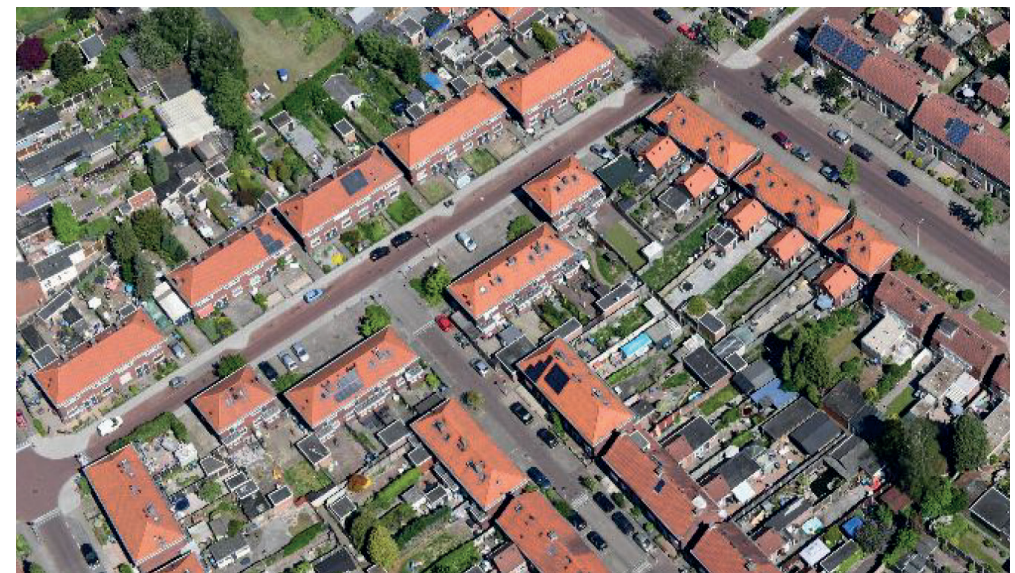
Landbouwstraat-Tarwestraat, stedenbouwkundige samenhang.
