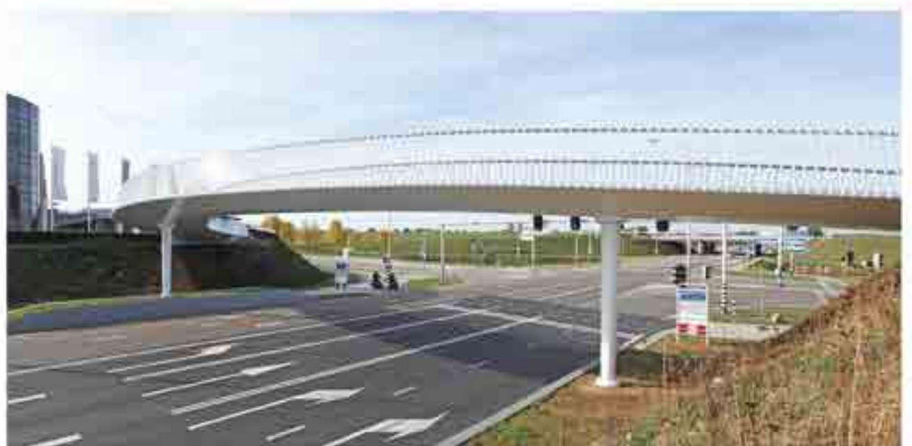
Referentie: fietsbrug in Delft
