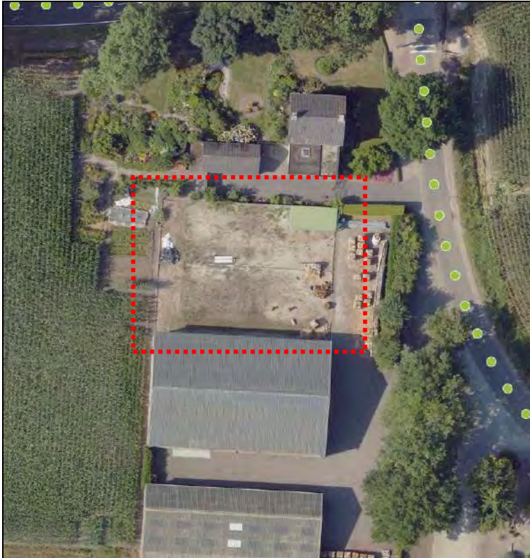
Figuur 13: Luchtfoto in aanbouw zijnde loods
