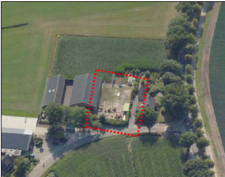
Figuur 14: Luchtfoto in aanbouw zijnde loods
