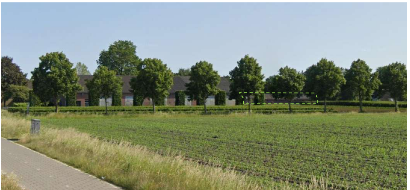
Aanzicht locatie vanaf N605 (zuidzijde, bushalte Peelsehuis), met aanduiding te slopen stal
