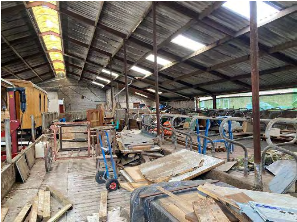
• Afbeelding 14: binnenzijde te slopen ligboxenstal
