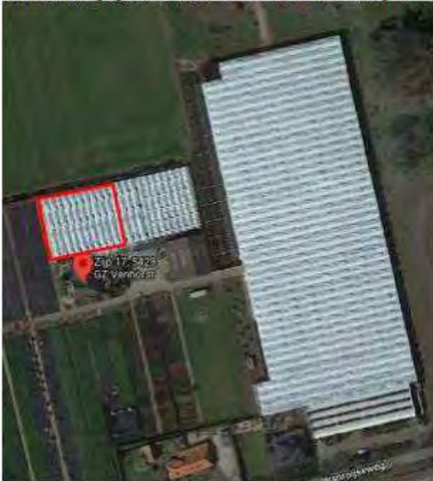
Figuur 162 Te slopen en saneren onderdelen
