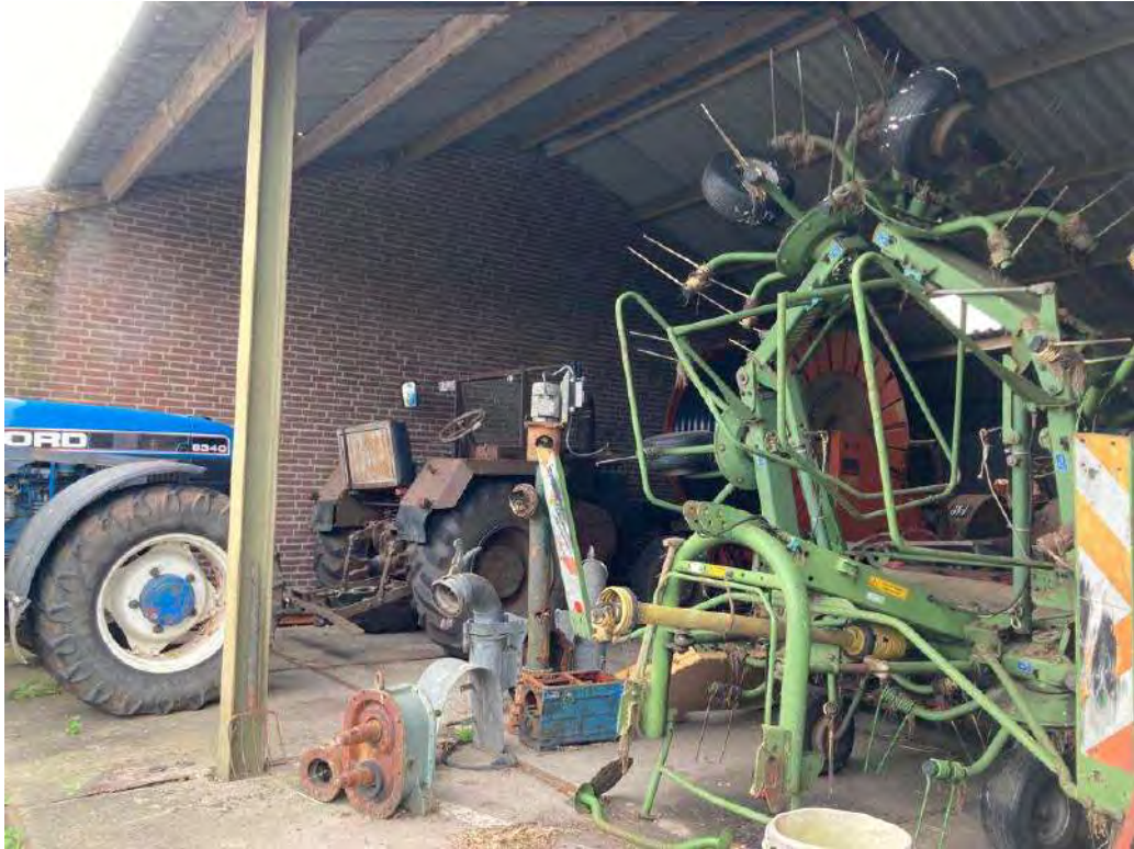
• Afbeelding 6: Te slopen loods achter voormalige varkensstal
