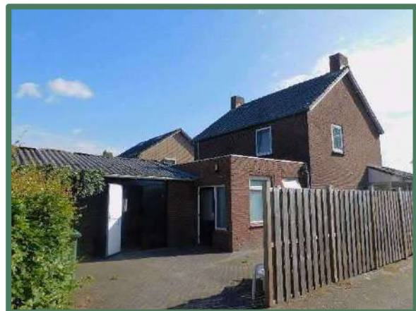
Achterzijde woning met aangebouwde varkensstal
