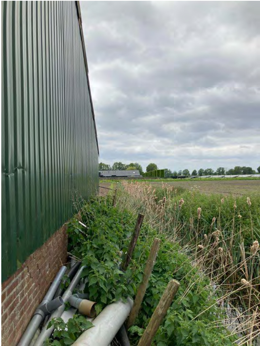
• Afbeelding 10: Sloot naast te slopen loods
