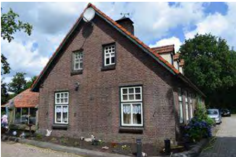
Figuur 199 Karakteristieke woonboerderij Schepersdijk 10
