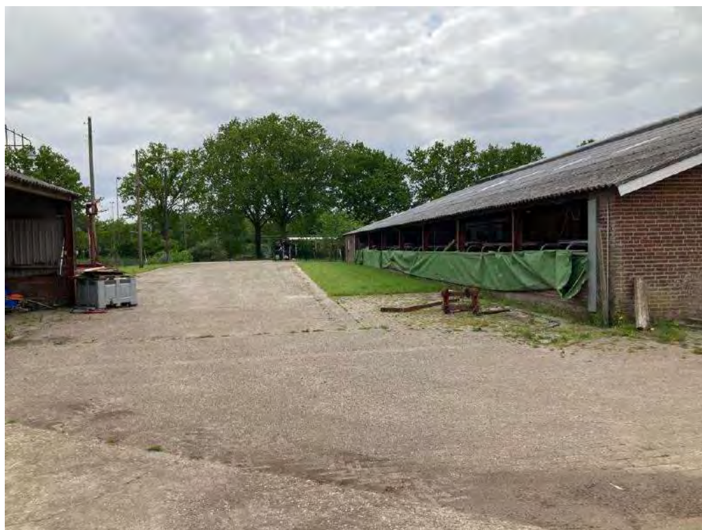
• Afbeelding 5: Terrein met erfverharding en gras tevens zijgevel te slopen ligboxenstal
