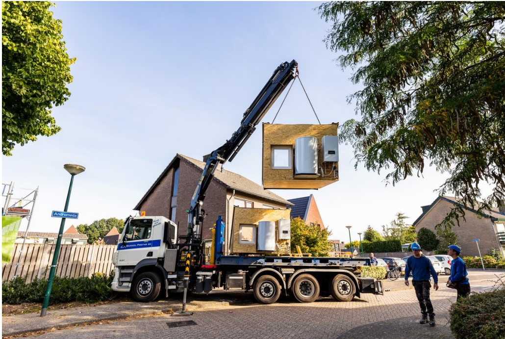
Afbeelding: Plaatsing HT skid aan de Andromeda in Loon op Zand door Casade (elektrische warmtepomp op hoog temperatuur - in combinatie met isoleren van de gevel, HR++ beglazing, een nieuw dak en zonnepanelen)
