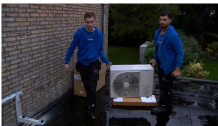
Medewerkers van Heattransformers installeren de buitenunit van een warmtepomp. »03
