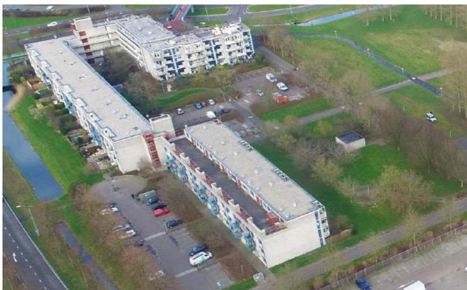
Bestaande bebouwing ensemble De Grietenij
