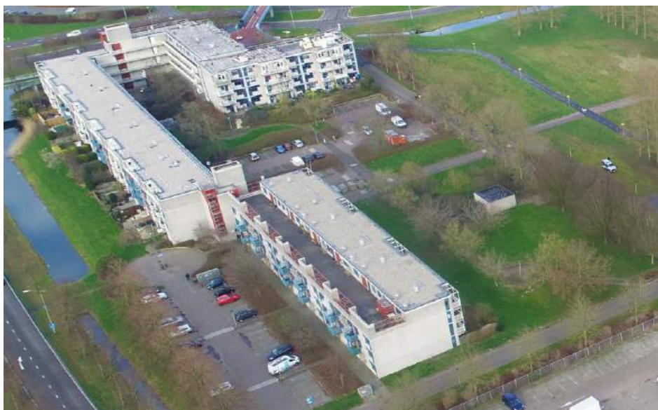
Bestaande bebouwing ensemble De Grietenij
