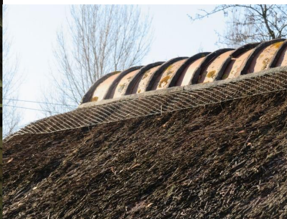
Afbeelding 10: Nokvorsten op het rieten dak.
