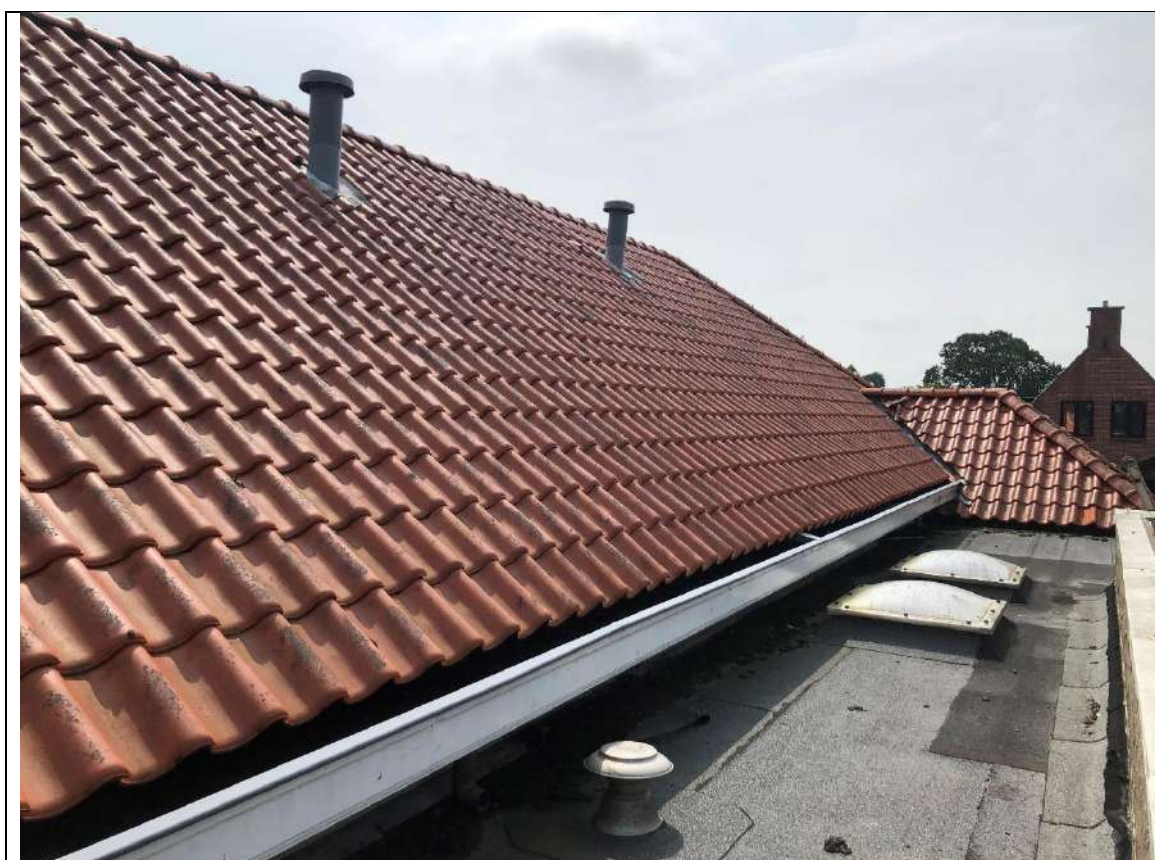
Figuur 1.7 Noordelijk dakvlak van gebouwdeel G
