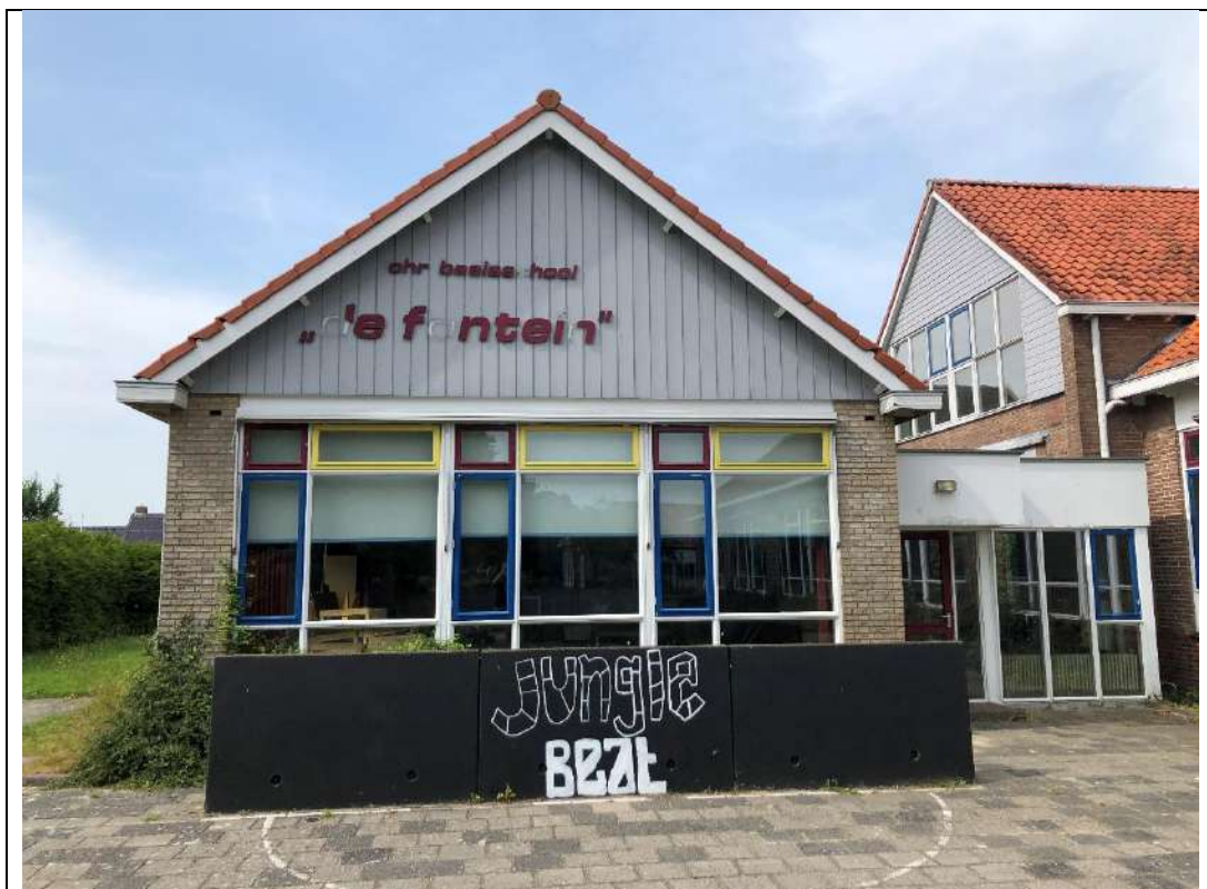
Figuur 1.4 Zuidgevel bouwdeel A, lage corridor is gebouwdeel B en helemaal rechts de westgevel van gebouwdeel C.
