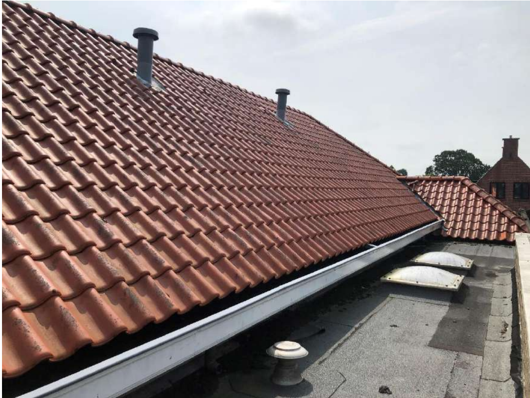
Figuur 1.7 Noordelijk dakvlak van gebouwdeel G
