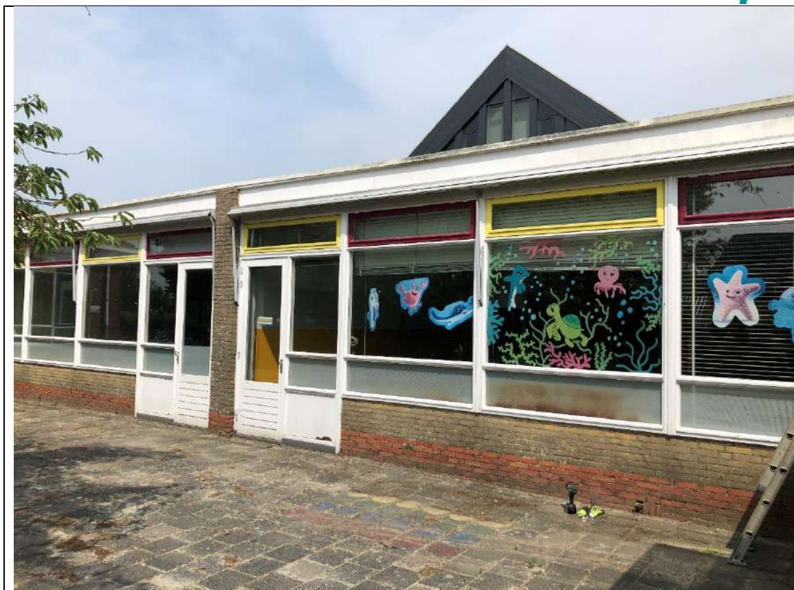
Figuur 1.6 Westgevel van gebouwdeel F.
