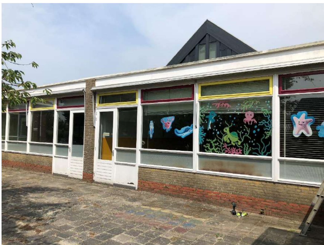
Figuur 1.6 Westgevel van gebouwdeel F.
