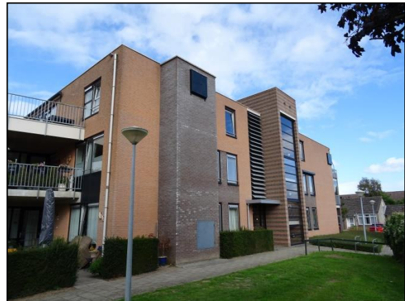
Figuur 12. Geplaatste kraamkast, zuidzijde.
