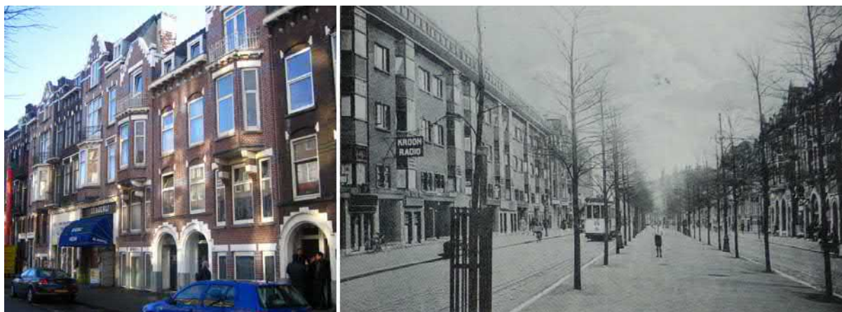
Figuur 3.2: bebouwing in retroarchitectuur en modernere architectuur aan de zuidzijde van de Schiedamseweg.
