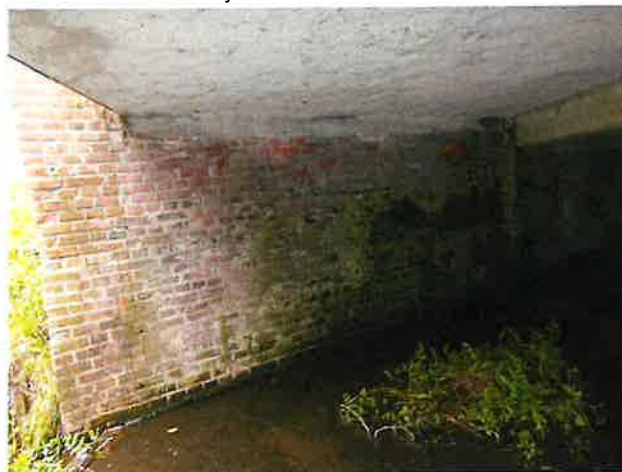
Foto 6: aanzicht landhoofd en onderzijde dek
