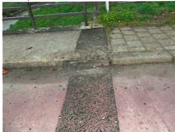
Foto 18: aanzicht voegovergang in voetpad
