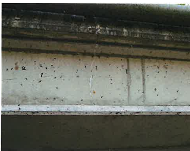
Foto 8: aanzicht scheur in ligger
