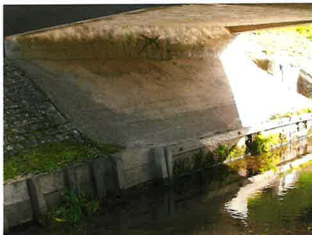
Foto 6: aanzicht landhoofd talud
