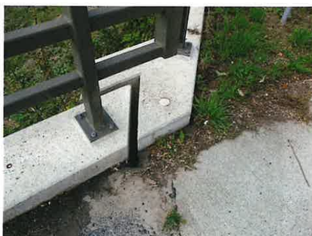
Foto 22: aanzicht opstaande voegovergang schamkant
