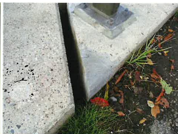
Foto 20: aanzicht betonreparatie schamkant
