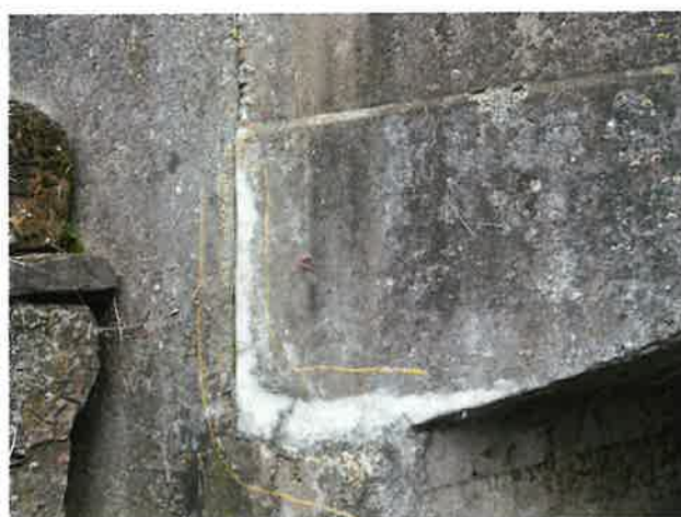
Foto 6: aanzicht betonschade
