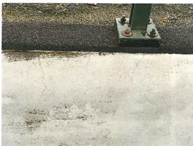
Foto 11: aanzicht krimp-scheurtjes in langsliggers
