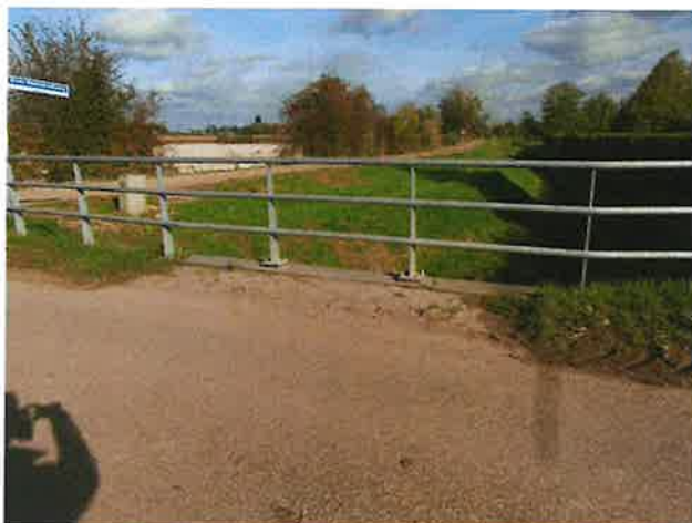
Foto 7: aanzicht straatwerk tussen schampkant en asflatverharding (oost)
