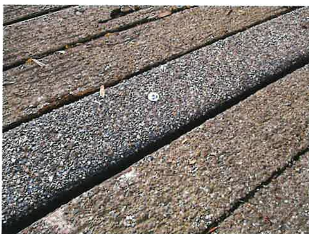
Foto 5: aanzicht vervangen plank
