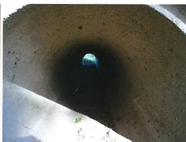
Foto 12: binnenzijde (west) duiker Noord
