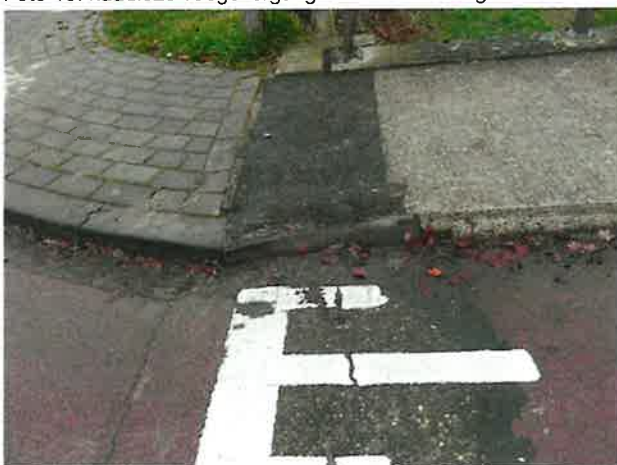
Foto 17: aanzicht voegovergang in voetpad
