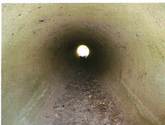
Foto 5: binnenzijde (oost) duiker zuid
