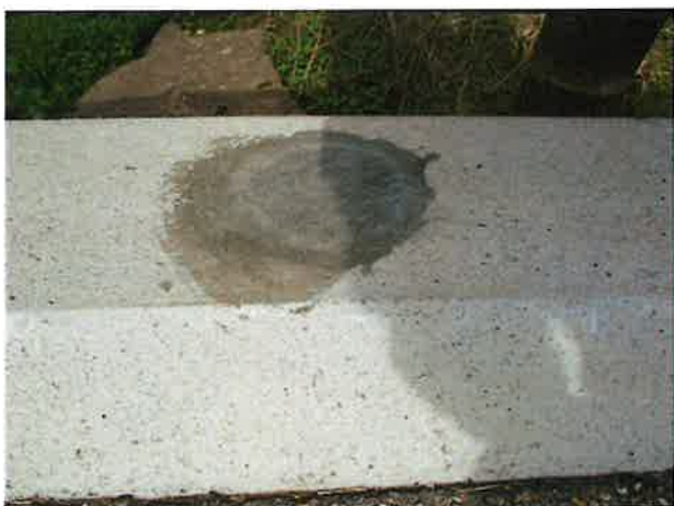
Foto 7: aanzicht herstelling/afdichting hijsoggat
