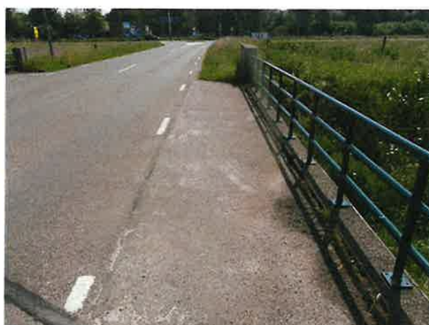
Foto 8: aanzicht slijtlaag op schampkant zuid
