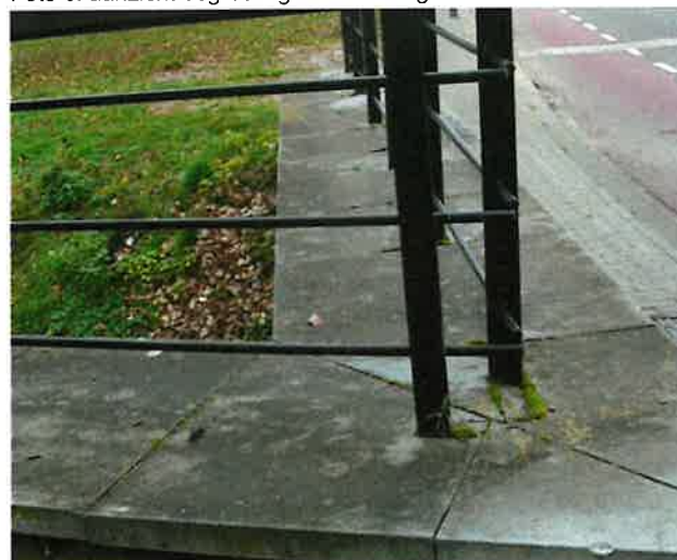
Foto 8: aanzicht mosvorming en begroeiing voegen hardsteen
