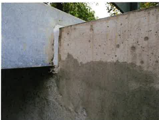
Foto 9: aanzicht betonopstorting vleugels landhoofd (zuid)
