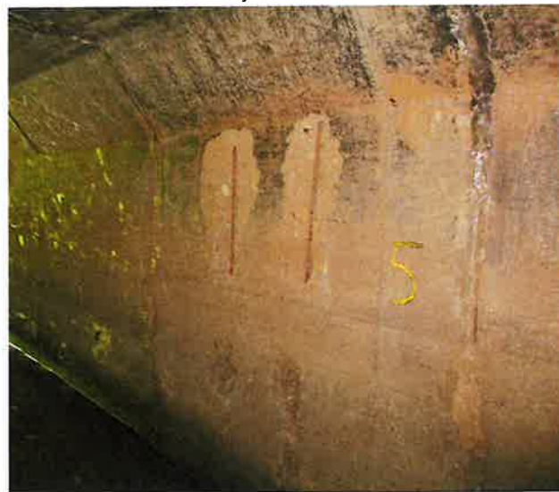
Foto 6: aanzicht dekkingschade
