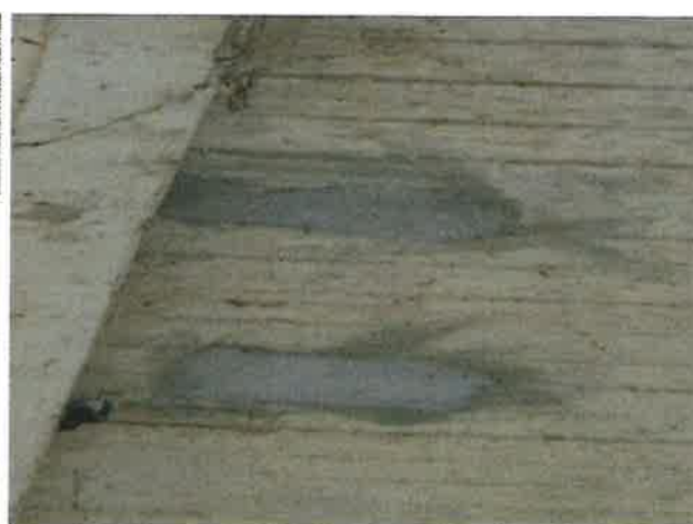
Foto 12: aanzicht betonreparaties
