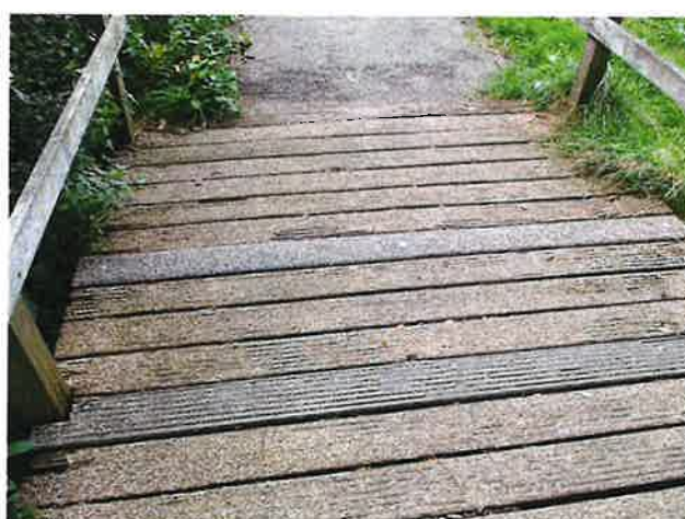
Foto 6: aanzicht vervangen planken
