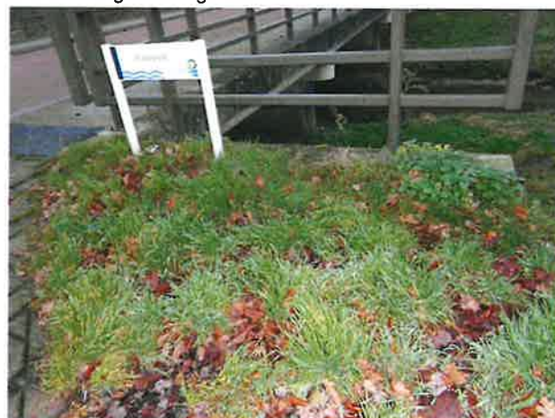
Foto 12: aanzicht begroeiing vleugelwanden
