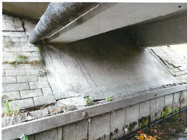
Foto 3: aanzicht landhoofd en onderzijde dek
