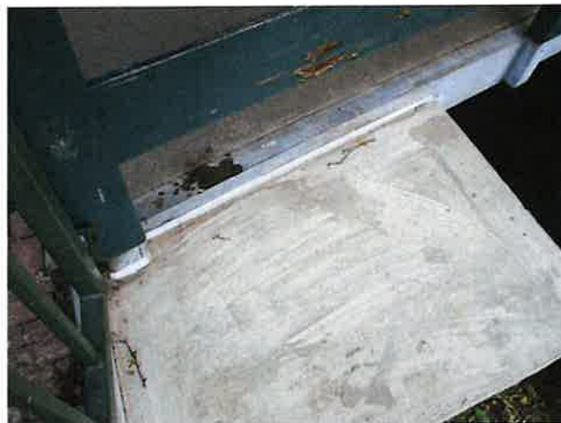
Foto 10: aanzicht betonopstorting vleugels landhoofd (noord)
