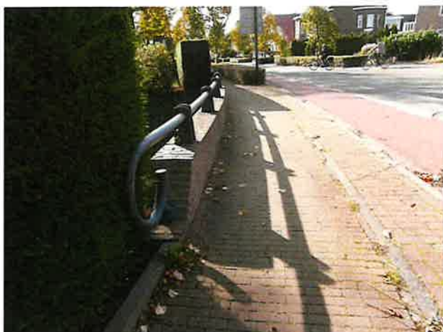
Foto 3: aanzicht elementenverharding en borstwering
