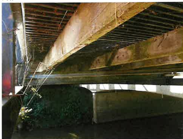
Foto 4: aanzicht landhoofd en onderzijde
