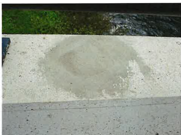
Foto 7: aanzicht herstelling/afdichting hijsoggat
