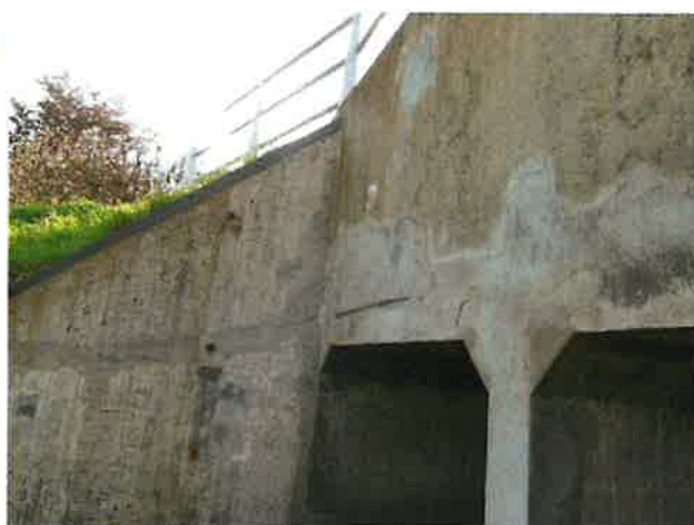
Foto 8: aanzicht betonreparatie
