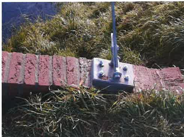
Foto 8: aanzicht herbevestiging leuningstijl
