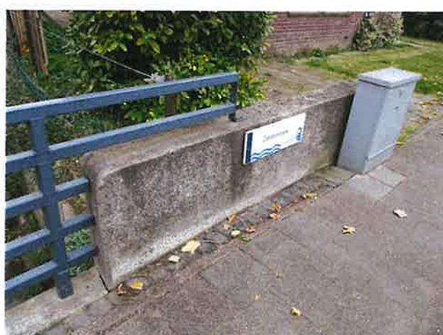
Foto 12: aanzicht vervuiling borstwering
