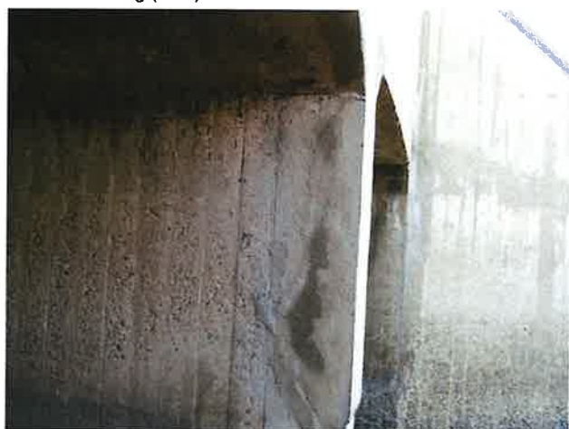
Foto 9: aanzicht betonreparatie
