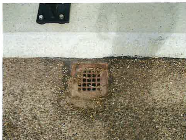
Foto 6: aanzicht vrijgemaakte afvoer
