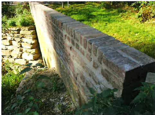
Foto 5: aanzicht herstelde borstwering
