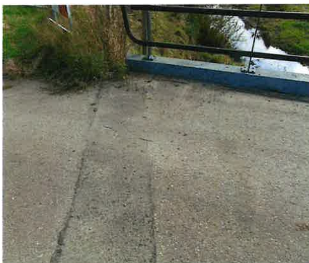
Foto 5: aanzicht bitumineuze voegovergang
