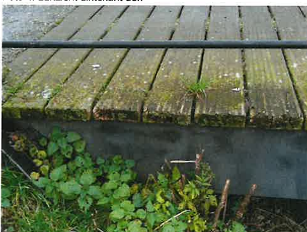
Foto 6: aanzicht plankdelen beginnend houtrot
