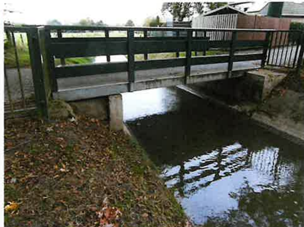
Foto 8: aanzicht noordelijk landhoofd / oeverbescherming
