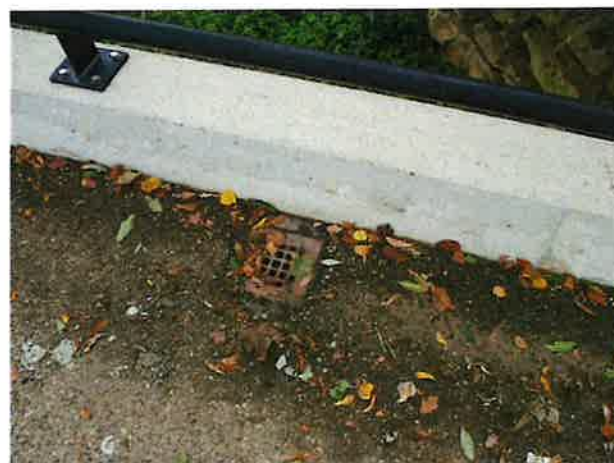
Foto 6: aanzicht vrijgemaakte afvoer
