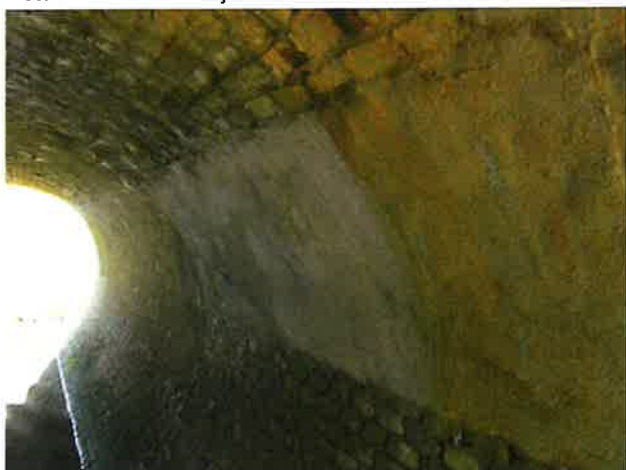
Foto 7: aanzicht herstelling wand
