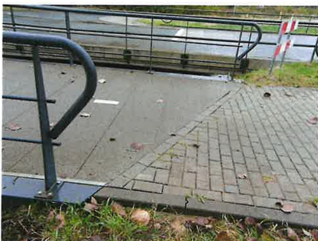
Foto 7: aanzicht aansluiting dek fietspad
