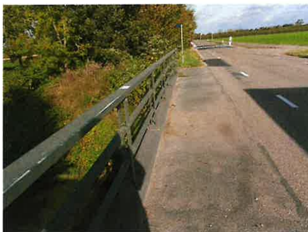
Foto 3: aanzicht slijtlaag verharde berm
