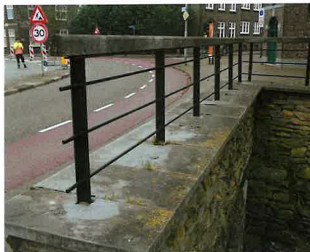
Foto 4: aanzicht mosvorming blauwwe hardsteen
