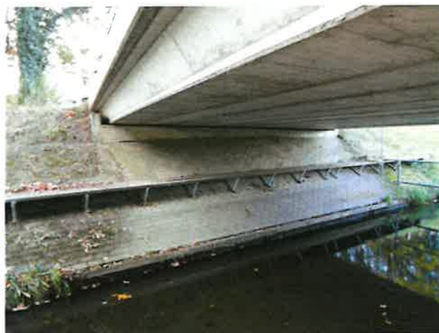
Foto 4: aanzicht landhoofd en talud
