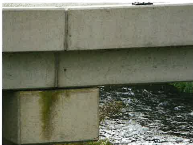
Foto 5: aanzicht oplegging tussensteunpunt
