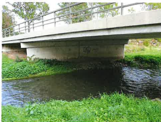
Foto 11: aanzicht noordelijk tussensteunpunt
