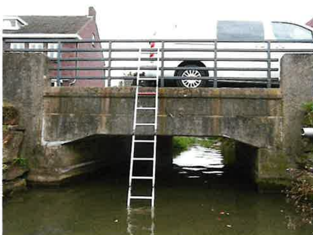
Foto 5: aanzicht landhoofden en frontwand westzijde
