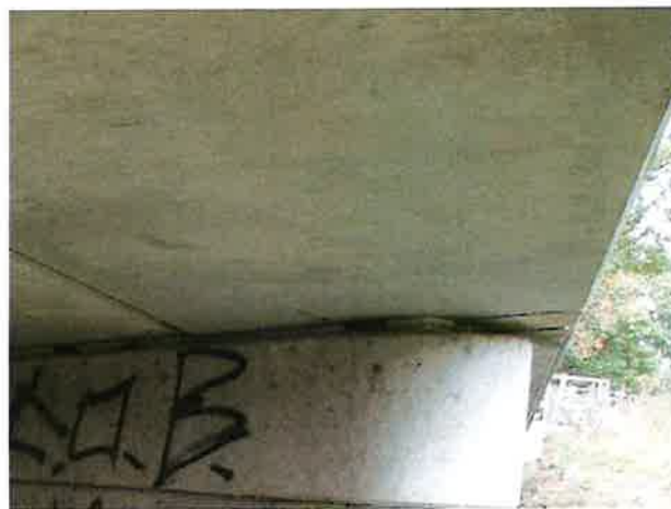
Foto 16: aanzicht oplegging tussensteunpunt
