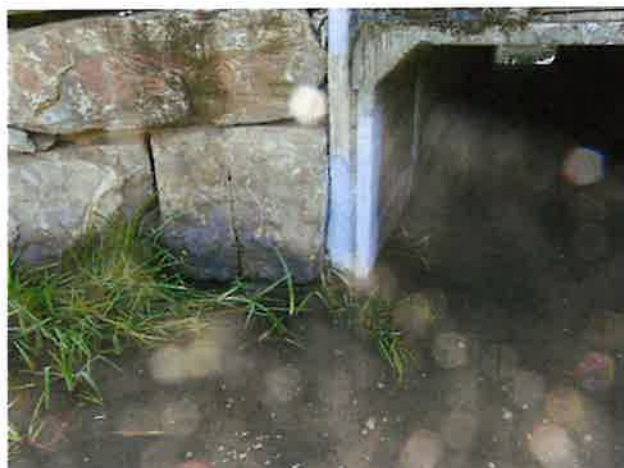
Foto 6: aanzicht herstelde dekkingschade
