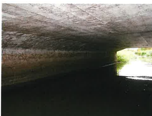
Foto 10: aanzicht onderzijde dek en landhoofd
