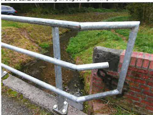
Foto 5: aanzicht vleugelwand van metselwerk
