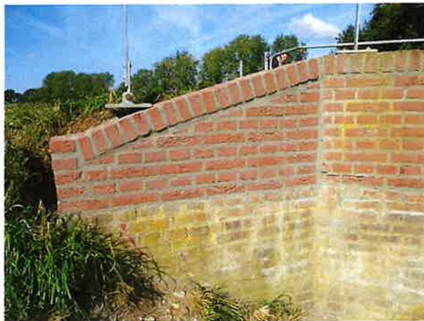
Foto 6 : aanzicht herstelde schampkant
