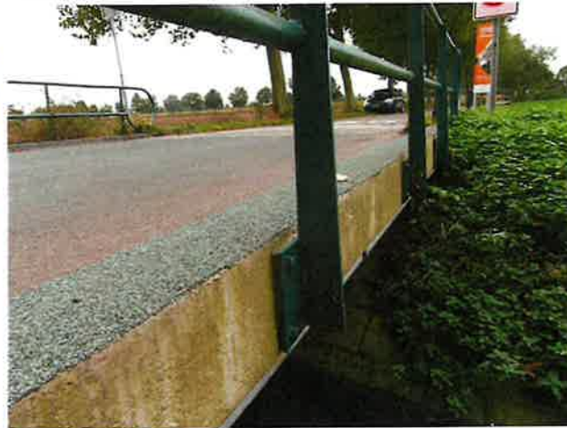
Foto 8: aanzicht slijtlaag
