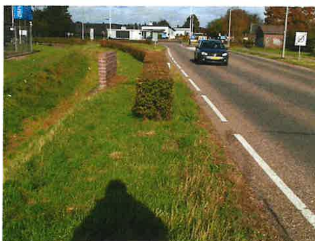
Foto 6: aanzicht borstwering (west)
