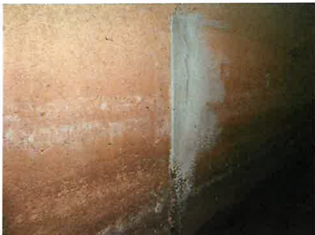
Foto 5: aanzicht herstelde dekkingschade
