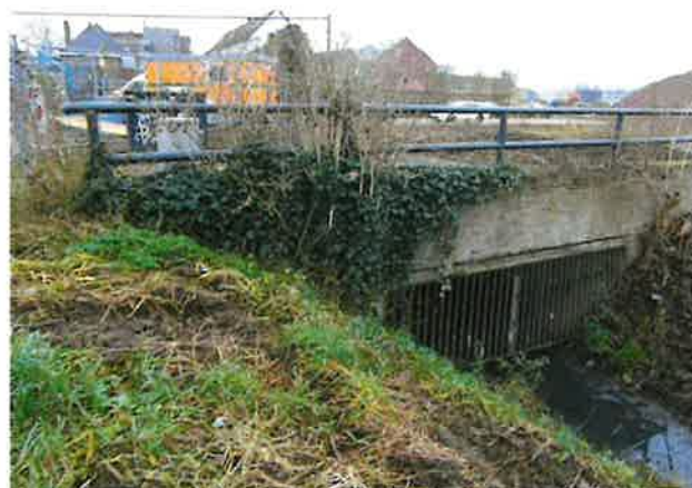
Foto 6: aanzicht begroeiing en vervuiling
