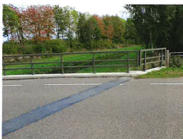
Foto 10: aanzicht zuidelijke voegovergang
