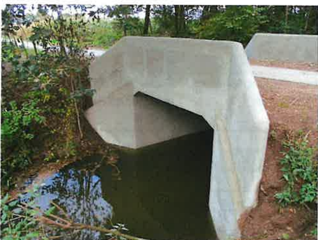
Foto 3: aanzicht frontwand west
