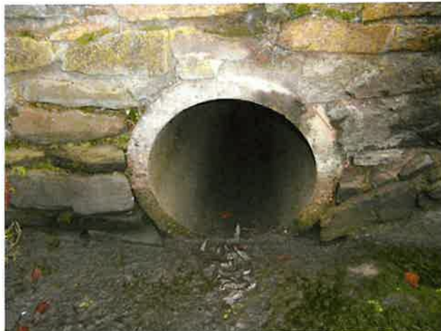
Foto 4: aanzicht betonnen buis
