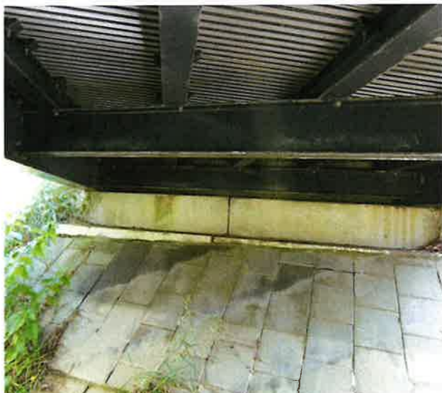
Foto 6: aanzicht landhoofd en dekconstructie
