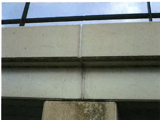
Foto 5: aanzicht oplegging tussensteunpunt
