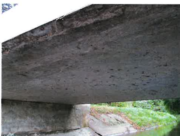
Foto 6: aanzicht onderzijde dek
