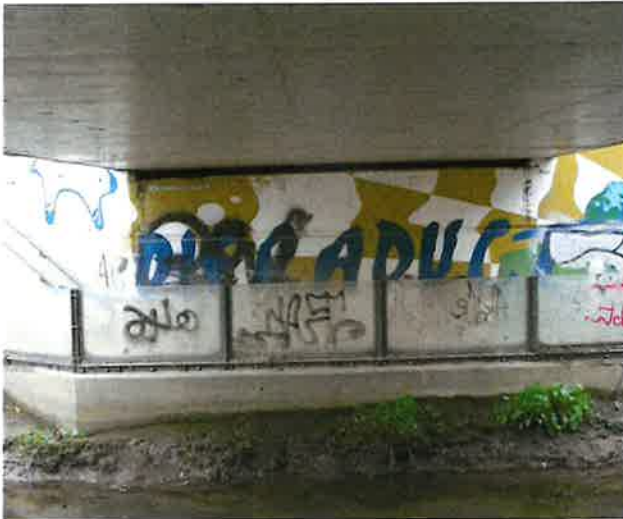
Foto 5: aanzicht keerwand en landhoofd zuid
