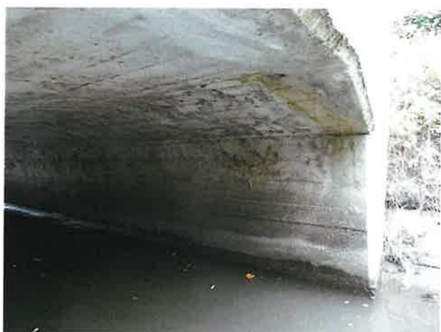
Foto 9: aanzicht onderzijde dek en landhoofd
