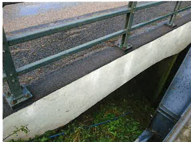
Foto 4: aanzicht slijtlaag schamprant
