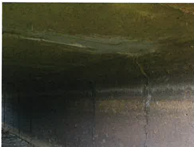
Foto 12: aanzicht herstelde dekkingschade
