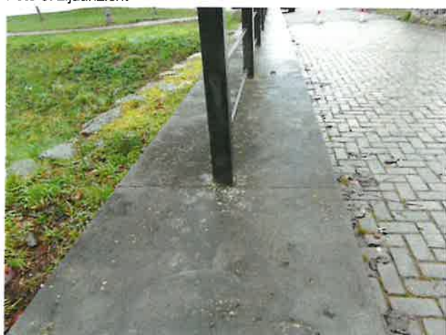
Foto 5: aanzicht afdekplaat blauwe hardsteen
