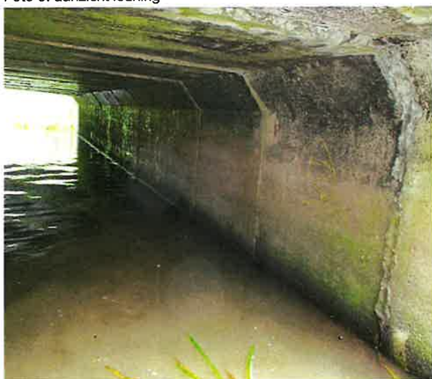
Foto 5: aanzicht binnenzijde duiker
