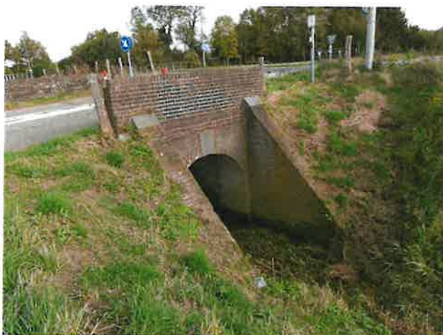
Foto 1: aanzicht frontwand met vleugelwanden
