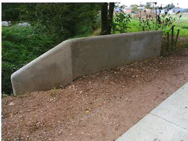
Foto 5: aanzicht borstwering west
