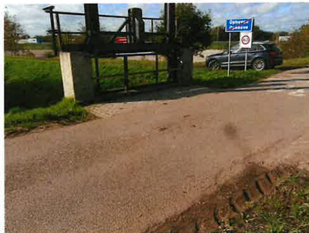
Foto 6: aanzicht straatwerk tussen schampkant en asflatverharding (west)
