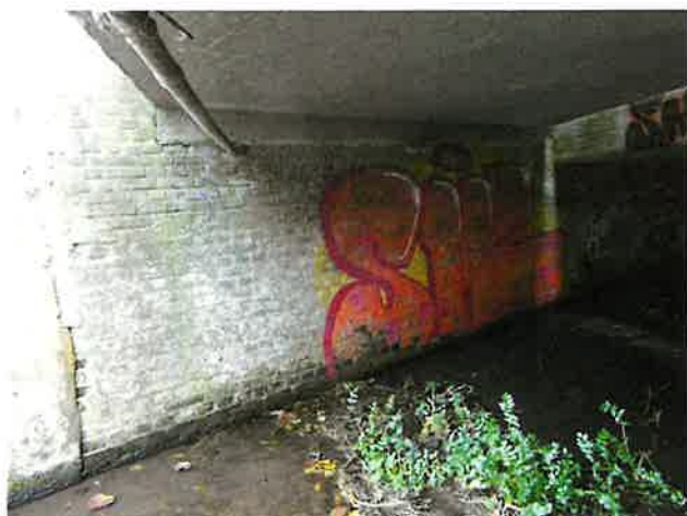
Foto 3: aanzicht landhoofd en onderzijde dek
