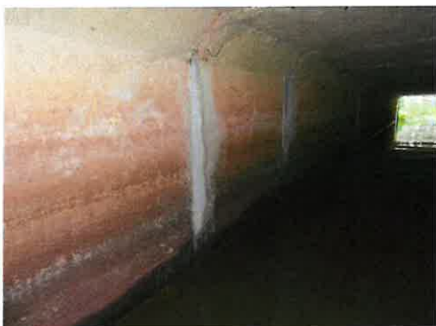
Foto 7: aanzicht herstelde dekkingschade
