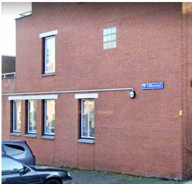
Zijgevels aan de steeg hebben kleinere gevelopeningen
