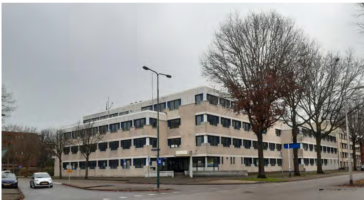
Foto 1: Zicht op het voormalig Belastingkantoor vanaf zuidelijke richting. Links op de foto de Lievekamplaan, rechts op de foto de Raadhuislaan. Langs de Raadhuislaan staan Amerikaanse eiken, waarvan de twee voorste nesten herbergen van ekster.
