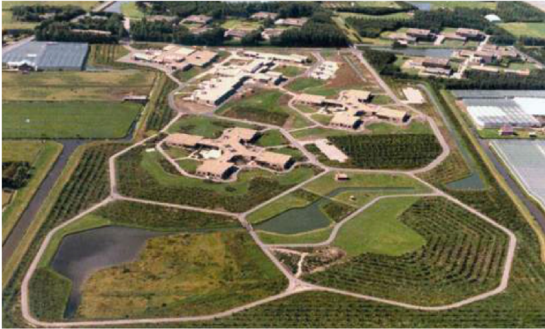
Westerhonk, net na de aanleg
