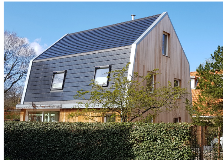
Mansardedak met zonnepanelen
