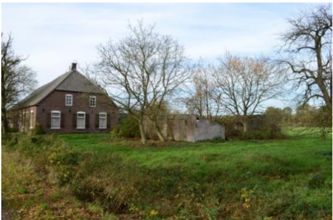
Figuur 2: Asbesthoudende bebouwing op perceel Mutshoek 2
