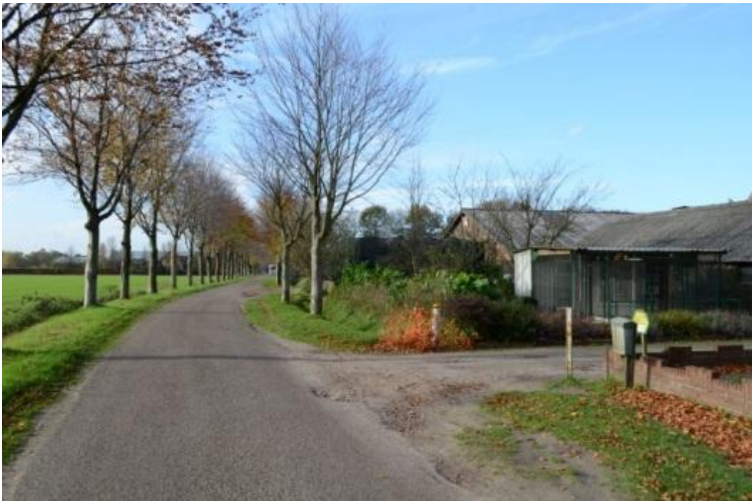
Figuur 8: Asbesthoudende bebouwing op perceel Lage Raam 6 (gezien in westelijke richting)
