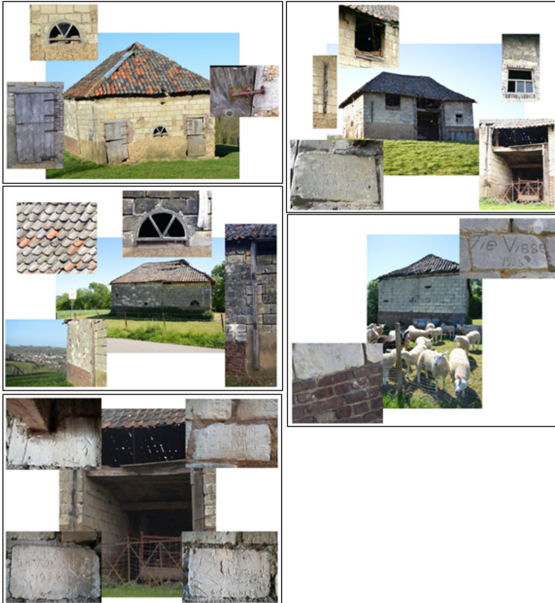
Bestaande situatie bebouwing/veldschuurtje
