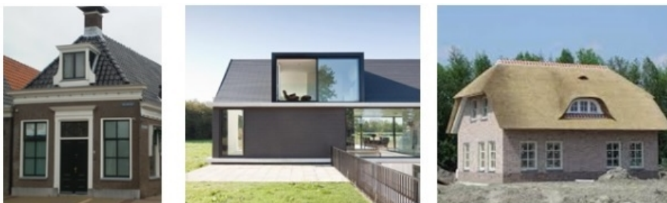
De bovenstaande dakkapellen voldoen allen niet aan een of meerdere objectgerichte criteria uit de bestaande welstandsnota.
