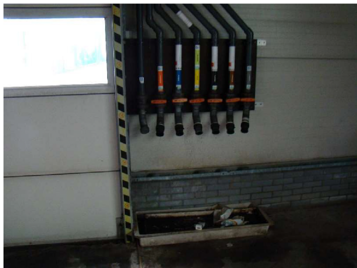
foto 21: Poelkade 32B (vulpunt vloeibare meststoffen)
