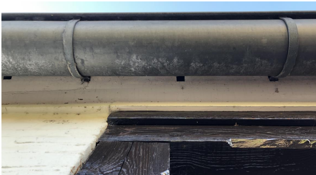
Figuur 11: Onderzijde dak met potentiële tijdelijke verblijfplaatsen vleermuizen, zie fig. 10.
