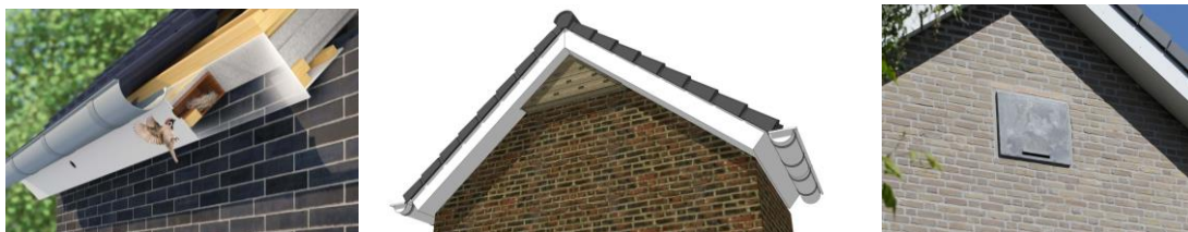
Figuur 10 a, b en c: Links: ingebouwde vleermuiskast. Rechts ingetekende nokkast en ingemetseld vleermuisverblijf.
