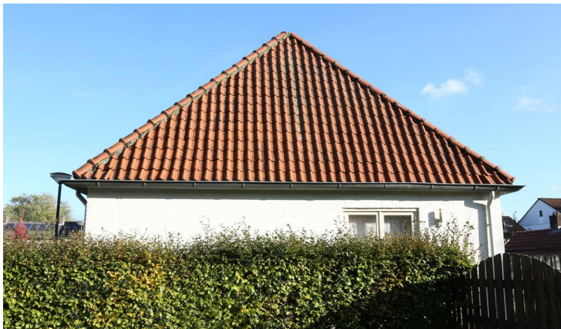
Figuur 9: Zicht op dak van een van de gebouwen, Brouwersstraat 1 - 3. Het dak is ongeschikt voor gierzwaluw en vleermuizen. Huismusnesten ontbreken eveneens.
