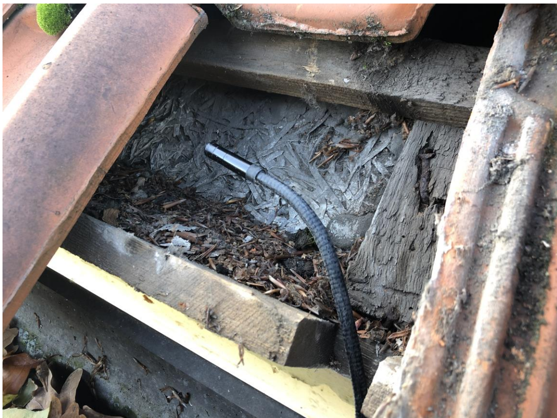
Figuur 12: Boven aanzicht inspectie dakbeschot met toegangswegen van onder de dakgoot, zie tevens fig. 11
