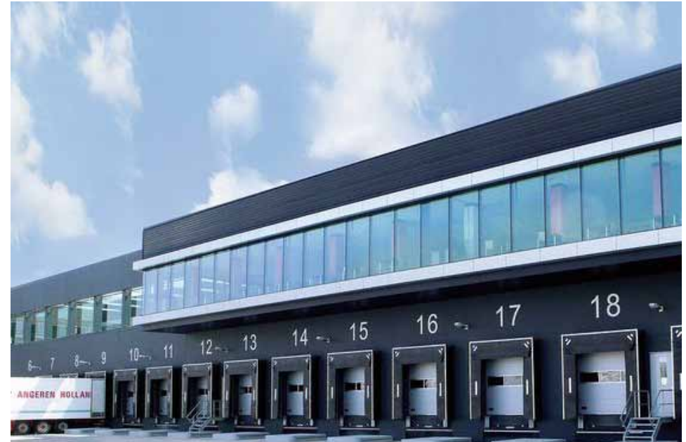
loading-docks met daarboven kantoor
