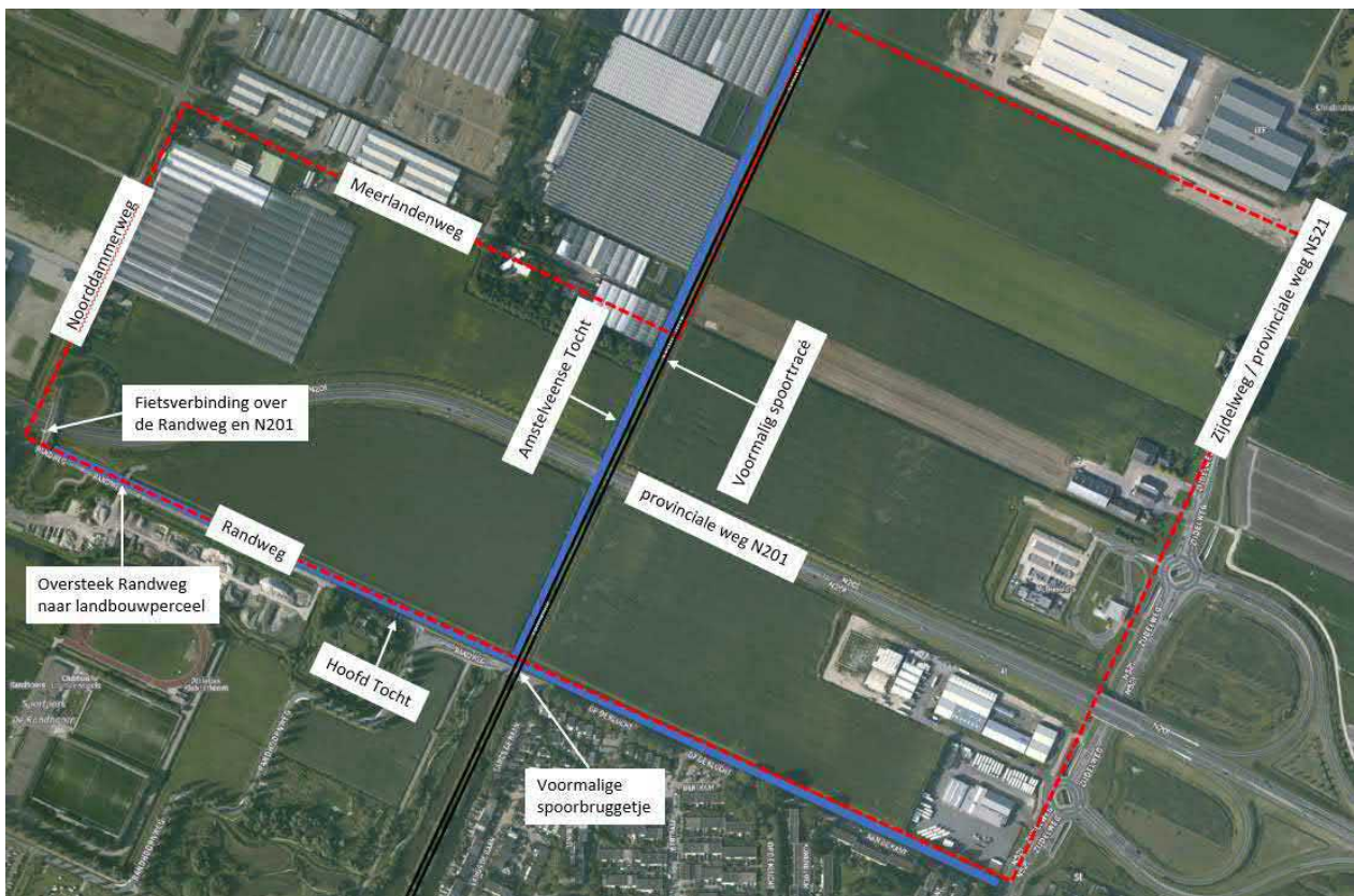
Figuur 3 Overzicht fysieke kenmerken in plangebied (bron: Cyclomedia)
