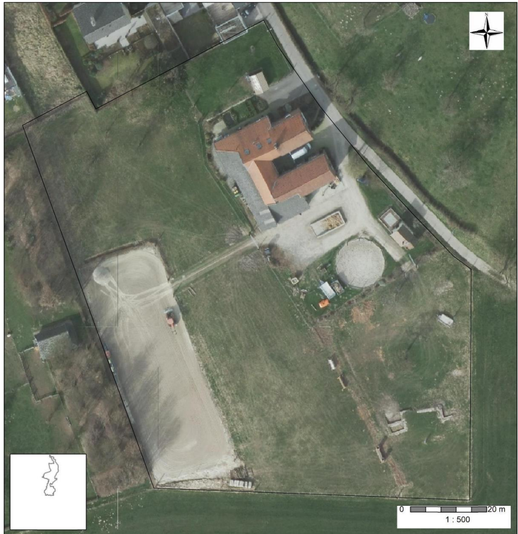
Figuur 3 Overzicht bestaande situatie
