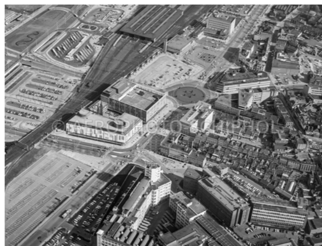
Eindhoven 1971, station en stationsgebied gezien vanaf de Witte Dame
