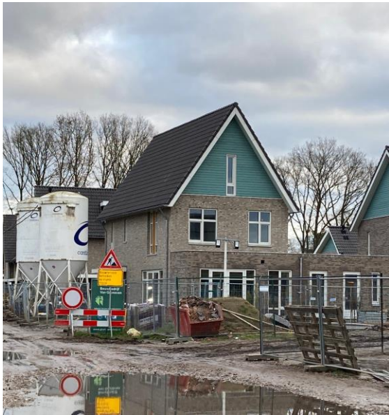
De bouw van de woningen in De Boslaantjes nadert de eindfase.
