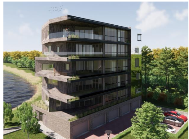
Zuidgevel woontoren Waderlo
