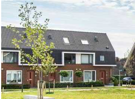
Mansarde kappen maken tweede bouwlaag mogelijk ondanks lage goothoogte
