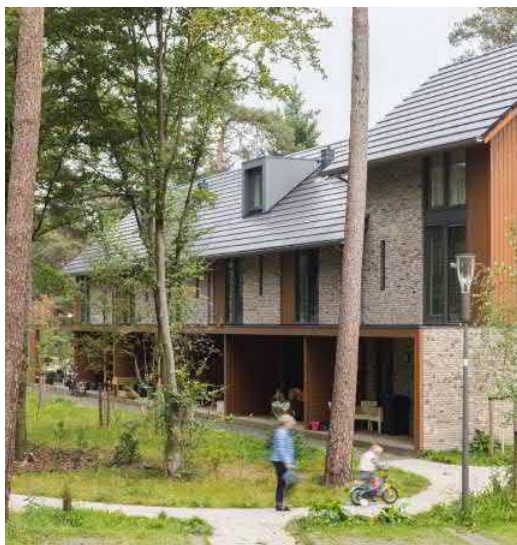
Terugliggende geveldelen grenzen aan het park
