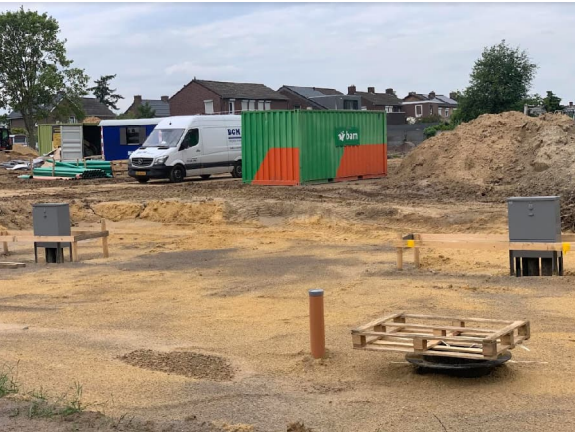
Figuur 37 Tijdelijke 'aansluitkastjes' in terrein.
