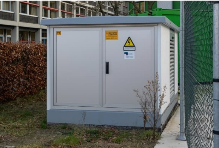
Figuur 40. Voorbeeld van een compactstation voor klantrafo's.
