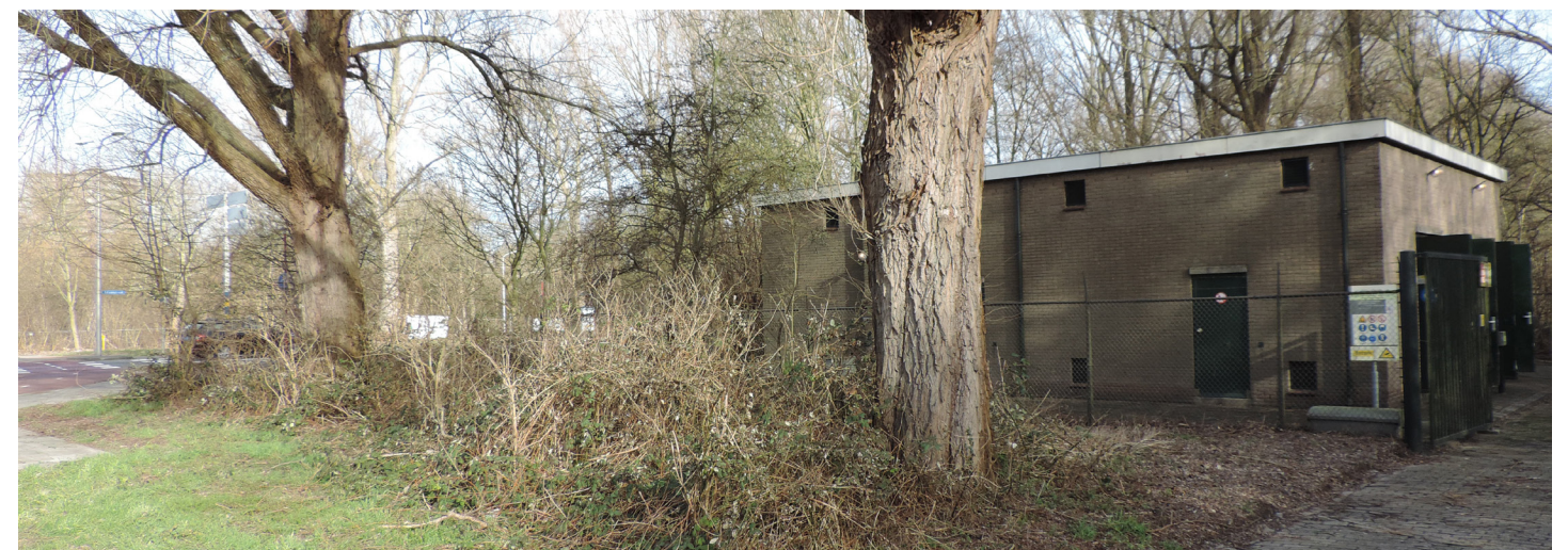
Gasverdeelstation aan de Van der Hagenstraat
