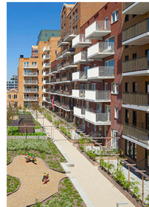
Appartementen aan een collectieve dektuin
