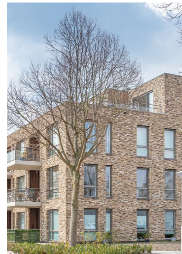
Diversiteit in hoogte, alzijdig georiënteerd
