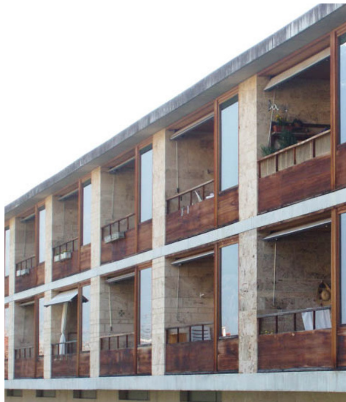
Inpandige buitenruimtes aan het park
