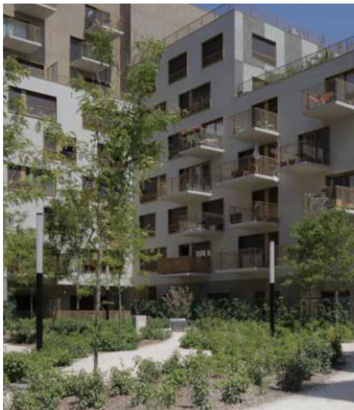
Adressen aan het park
