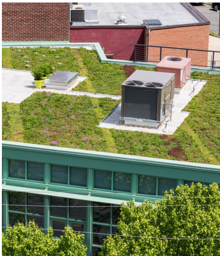
Technische voorzieningen worden zorgvuldig ingepast op het dak.
